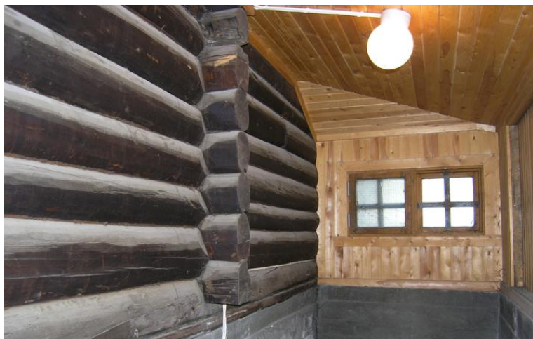
Innvendig vegg i tilbygget. Opphavsrett: Statsbygg.
