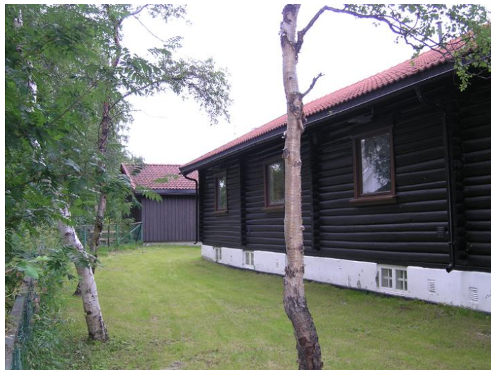
Fasade mot syd. Opphavsrett: Statsbygg.
