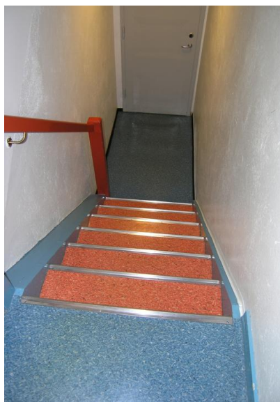
Nedgang til kjeller. Opphavsrett: Statsbygg.
