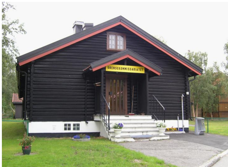
Fasade øst med inngangspartiet. Opphavsrett: Statsbygg.
