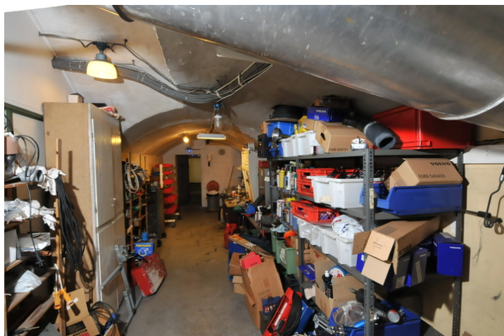
Tverrkorridor mot gassluse. Foto: Leif Anker, Forsvarsbygg
