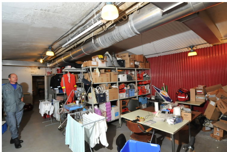
Forlegning rom 20 sett mot rom 5. Foto: Leif Anker, Forsvarsbygg
