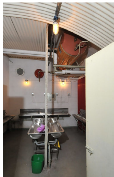
Vaskerom og toaletter. Foto: Leif Anker, Forsvarsbygg
