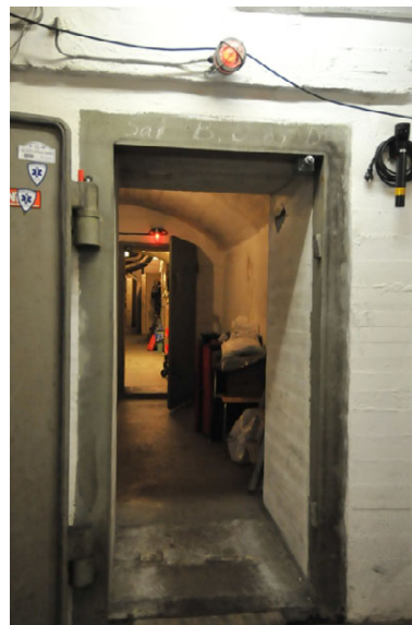
Gassluse til tverrkorridor. Foto: Leif Anker, Forsvarsbygg
