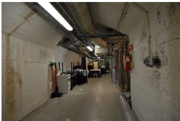
Garasje og inngangssluse. Foto: Leif Anker, Forsvarsbygg.
