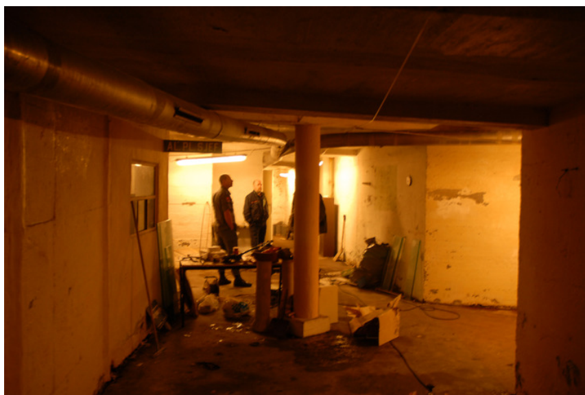
Oppholdsrom. Kontor t.v. Foto: Erlend Hammer, Forsvarsbygg.
