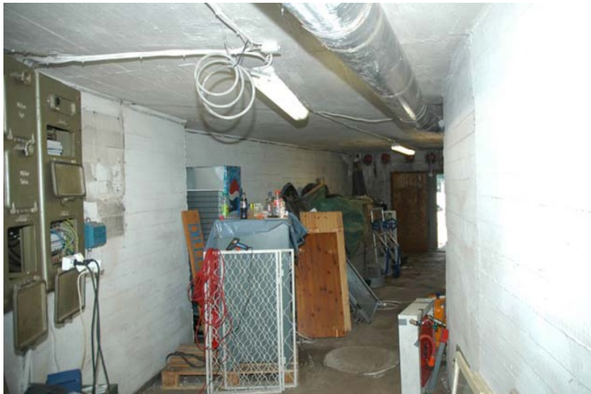
Garasje mot utgangsdør. Foto: Kjetil Nergaard, Forsvarsbygg.
