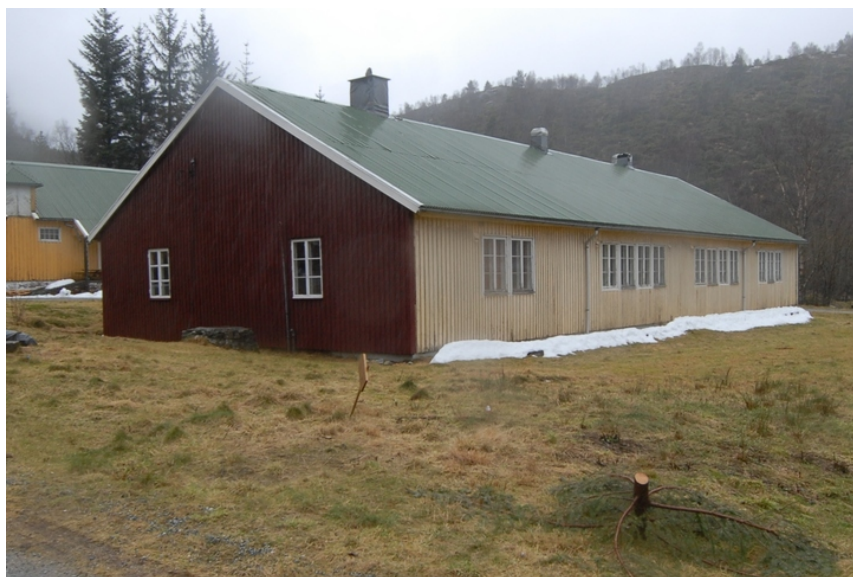
Brakke II (bygg 3), sett fra NØ. Bak skimtes bygg 7. Foto: Leif Anker.
