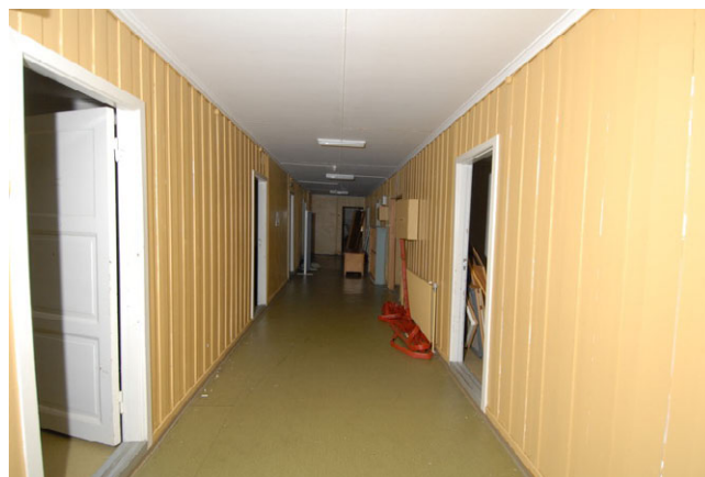
Korridor mot øst. Foto: Leif Anker, Forsvarsbygg
