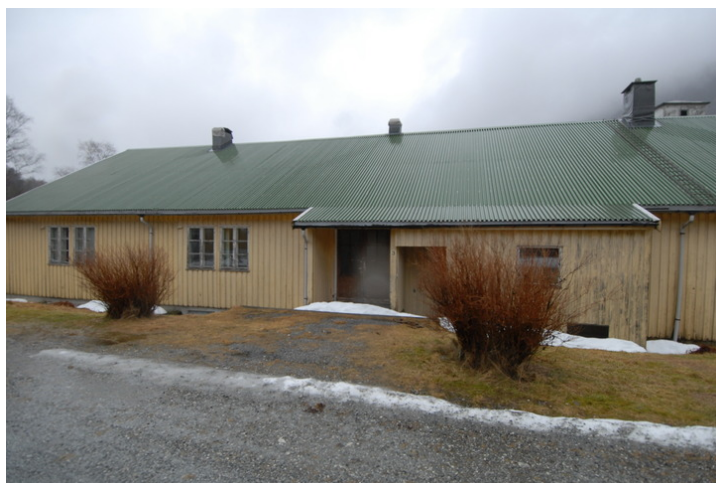
Inngangsparti i sør. Foto: Leif Anker, Forsvarsbygg
