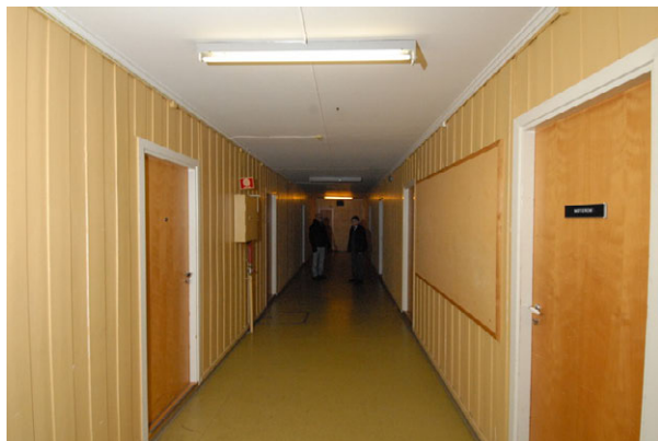
Korridor. Foto: Leif Anker.
