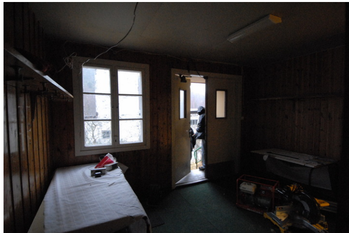
Vindfang mot ytterdør. Foto: Leif Anker, Forsvarsbygg.
