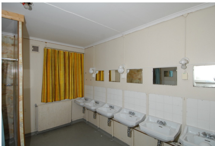
Bad/vaskerom mot sør. Foto: Leif Anker, Forsvarsbygg
