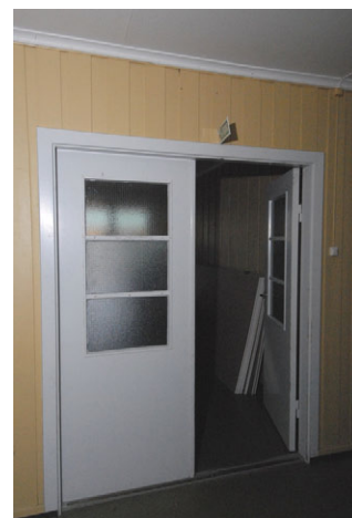
Tofløyett dør korridor mot bislag. Foto: Leif Anker, Forsvarsbygg
