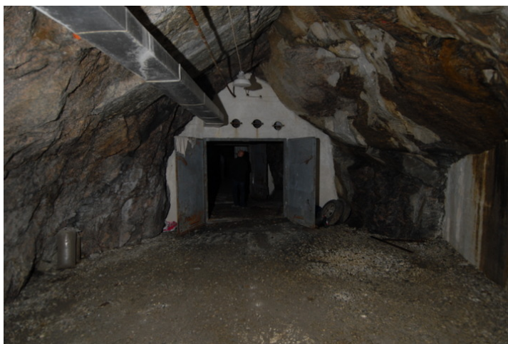
Materiellplass mot sluse. Foto: Leif Anker, Forsvarsbygg
