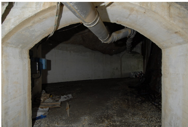
Garasje mot utgang. Foto: Leif Anker, Forsvarsbygg
