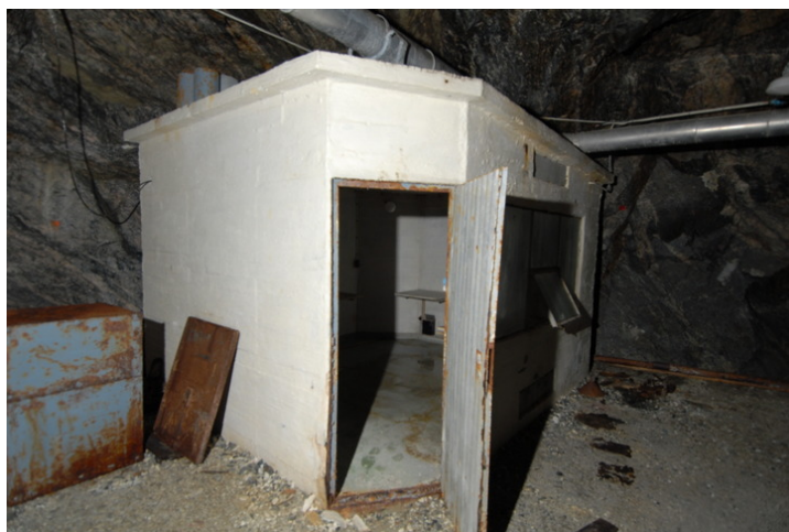
Inngang kontor plassjef. Foto: Leif Anker, Forsvarsbygg
