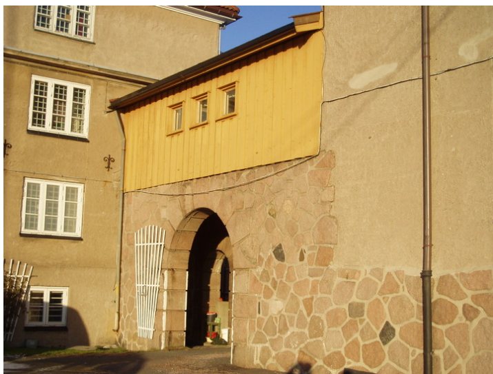
Forbindelsesgangen mellom adminstrasjons- og internatbygg. Sørsiden. Opphavsrett: Statsbygg.
