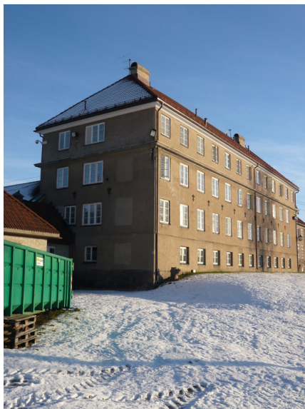
Internatbygning, vest- og sørsiden. Opphavsrett: Statsbygg.
