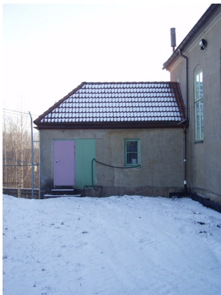
Agregatbygning vestsiden. Opphavsrett: Statsbygg.
