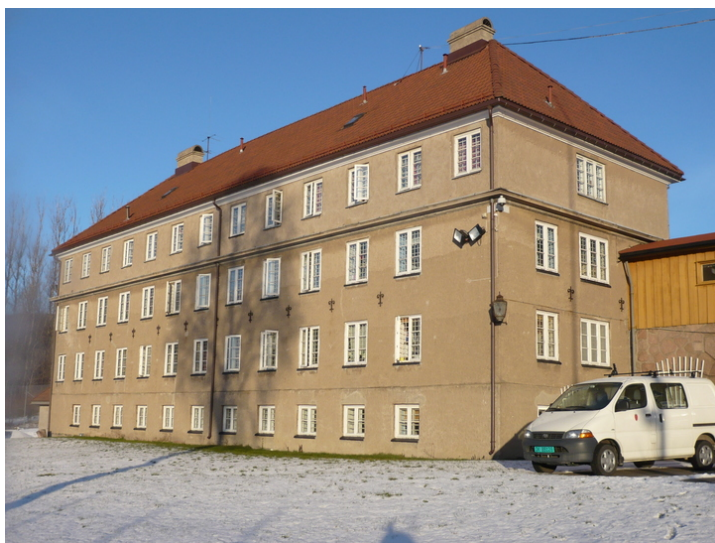
Internatbygningen. Sør og østsiden Opphavsrett: Statsbygg.
