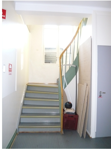
Trapp. Opphavsrett: Statsbygg.
