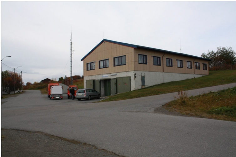
Anlegget sett mot NØ. U-bygg nærmest, nedgang kpl skimtes bak. Foto: Tore Pettersen, DSB.
