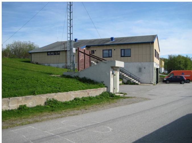
Oversiktsbilde tatt fra vest. Foto: Frode Karlsen, Forsvarsbygg.
