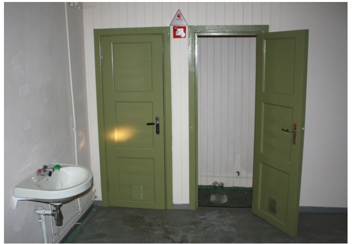
Toalettrom og vask sett fra forl.rom (rom 8). Foto: Tore Pettersen, DSB.
