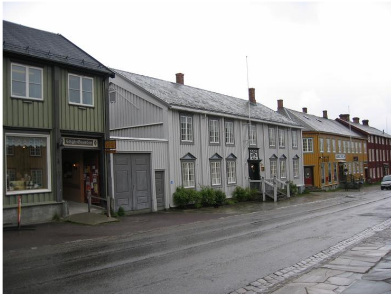
Bergskrivergården midt i bildet med Leighgården ovenfor og Bredalsgården og Finngården nedenfor. Opphavsrett: Statsbygg.
