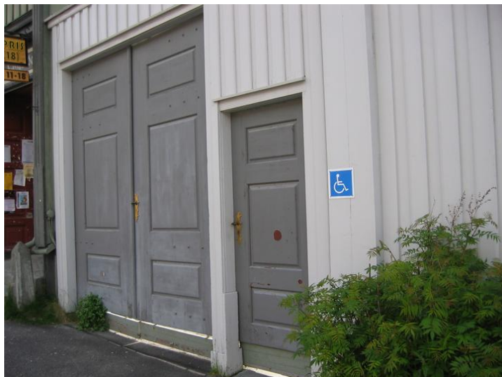
Inngang til gårdsrommet gjennom tofløyet port eller gjennom døra til høyre Opphavsrett: Statsbygg.
