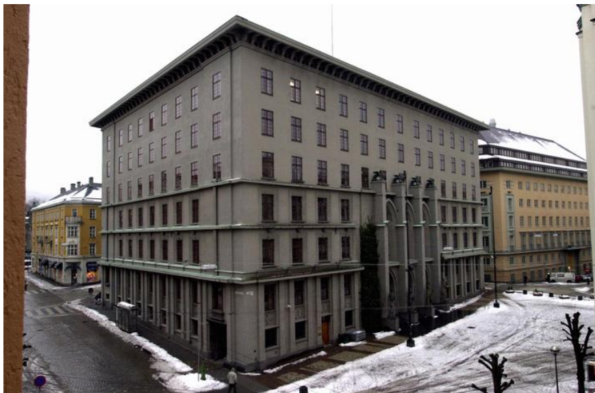
Bergen Tingshus mot vest Opphavsrett: Statsbygg.
