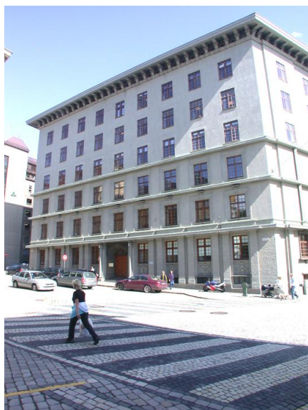
Fasade syd Opphavsrett: Statsbygg.
