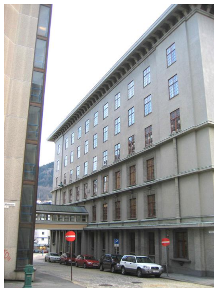
Fasade vest Opphavsrett: Statsbygg.
