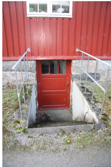
Eldre kjellerdør og nyere kledning. Opphavsrett: Statsbygg.
