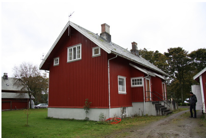
Fasade mot øst. Opphavsrett: Statsbygg.
