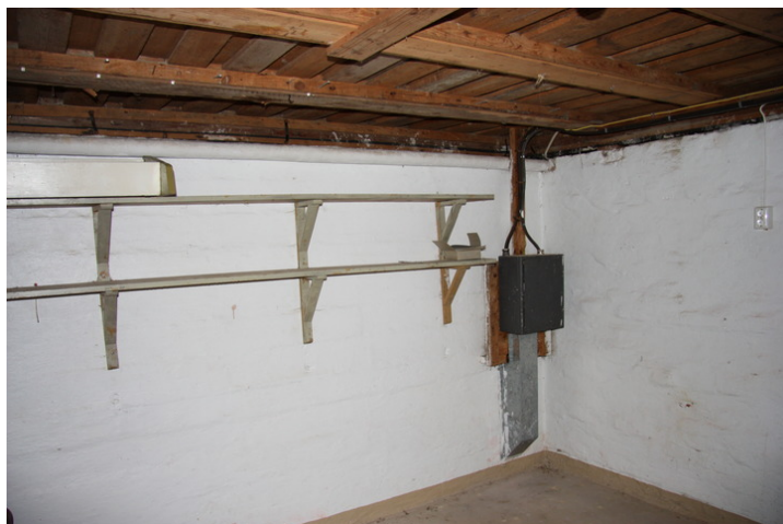
Lagerbod i kjelleren. Opphavsrett: Statsbygg.
