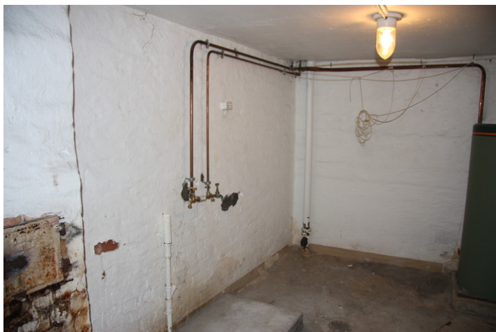
Vaskekjeller. Opphavsrett: Statsbygg.
