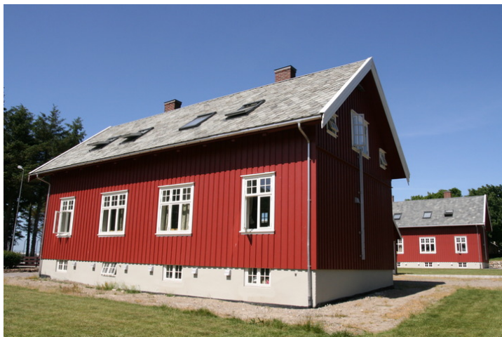
Fasader mot hagen, sør. Opphavsrett: Statsbygg.
