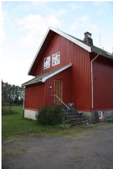
Inngangspartiet i utbygg på galvveggen med et snev av jærhusets skuter. Opphavsrett: Statsbygg.
