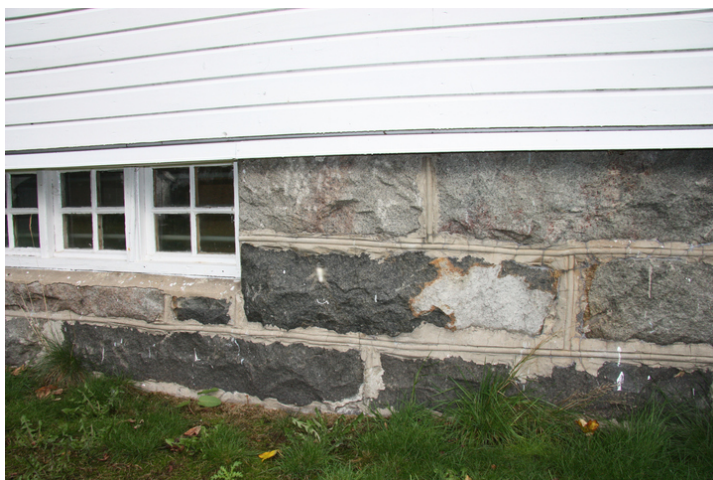
Detalj fra grunnmuren. Opphavsrett: Statsbygg.
