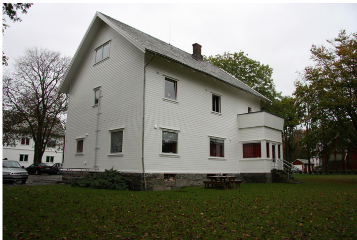
Direktørboligen mot hagen. Bygningens veranda er bygget inn. Opphavsrett: Statsbygg.
