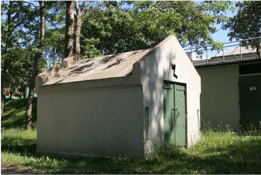
Bensinhus. Fasade mot øst. Opphavsrett: Statsbygg.
