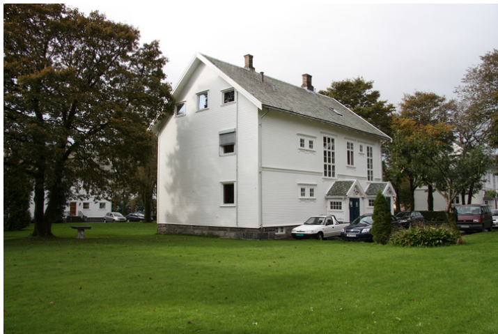
Hvitgata 3 har blanding av nyere og eldre vinduer. Opphavsrett: Statsbygg.
