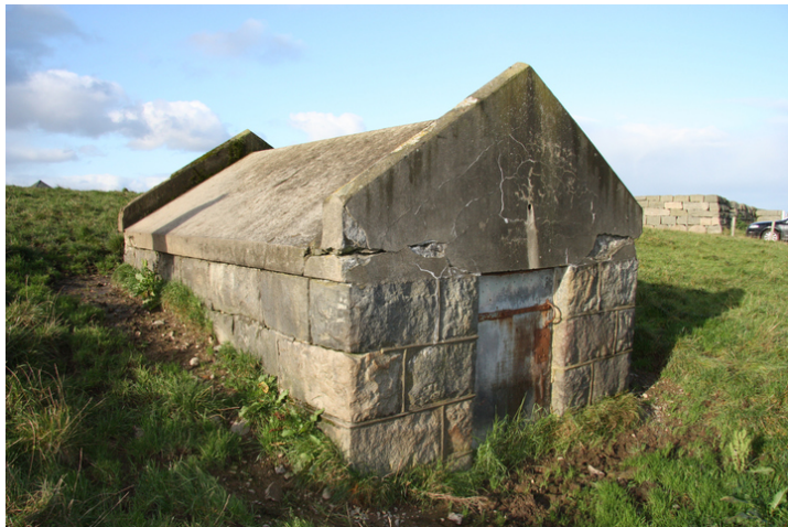
Dynamitthus med ståldør. Opphavsrett: Statsbygg.
