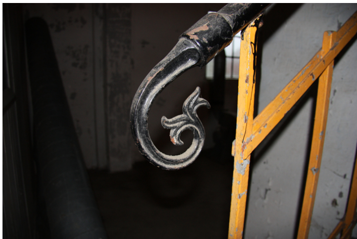
Detalj fra trappegelender i silotårnet. Opphavsrett: Statsbygg.
