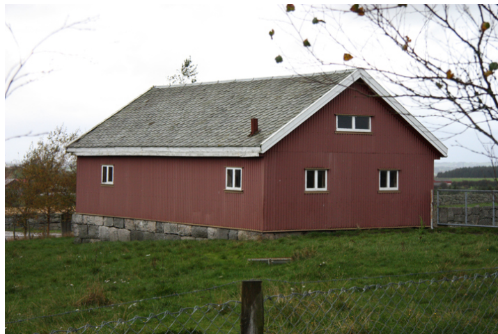
Bygningen er oppført på steinmur og taket tekket med skifer. Ytterkledningen, som opprinnelig var panel, er erstattet av plater. Opphavsrett: Statsbygg.
