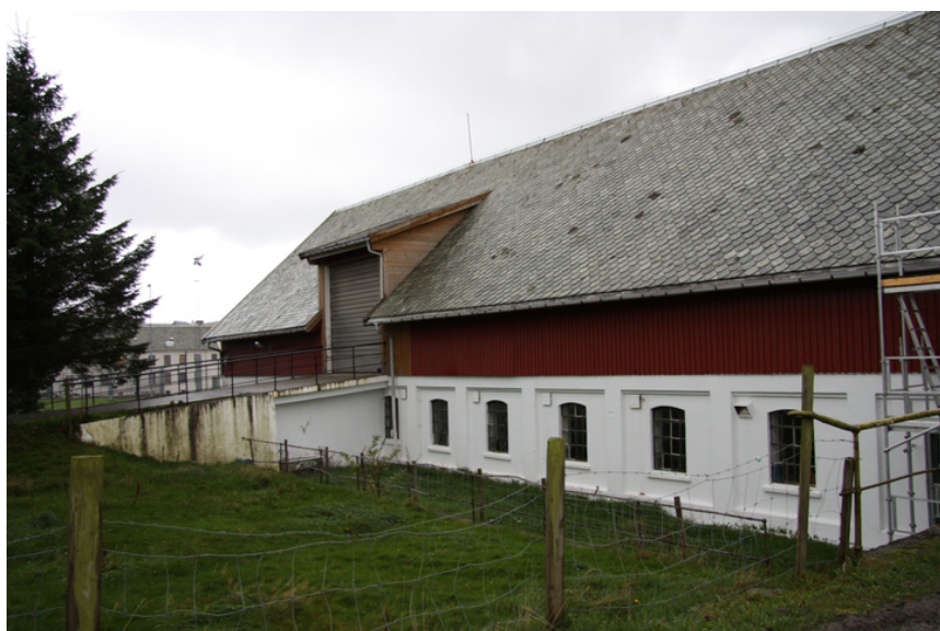
Østfløyen med låve over og stall under. Hovedbygningen skimtes i bakgrunnen. Opphavsrett: Statsbygg.
