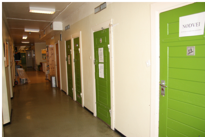
D-fløyen som ble bygd til på 1920-tallet er lite endret. Planløsning og interiørelementer er i stor grad bevart. Opphavsrett: Statsbygg.
