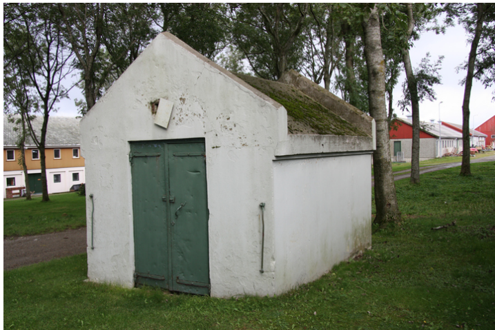
Bensinhuset for lagring av brennbare væsker. Tømmermannsverkstedet sees i bakgrunnen til venstre. Opphavsrett: Statsbygg.
