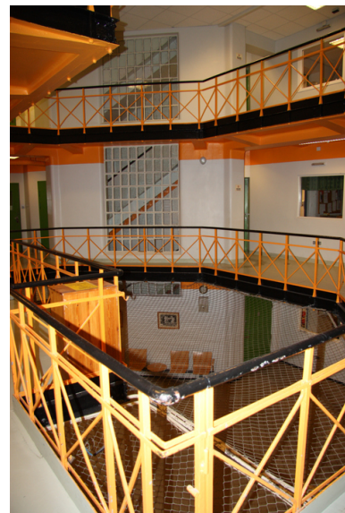
Fra midthallen var det opprinnelig åpent til de tre cellefløyene, i tre etasjer. Opphavsrett: Statsbygg.
