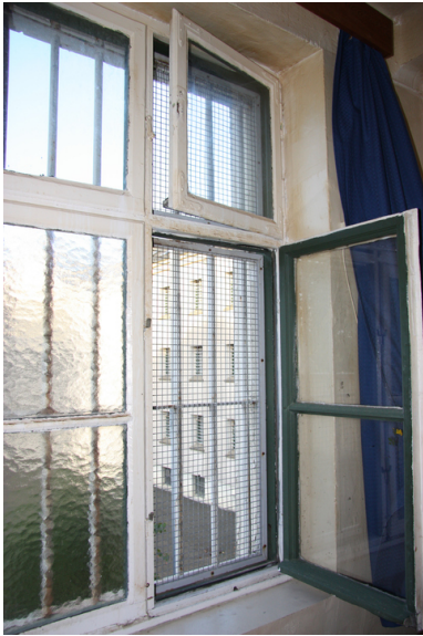
Originalt vindu i cellene i D-fløyen. Opphavsrett: Statsbygg.
