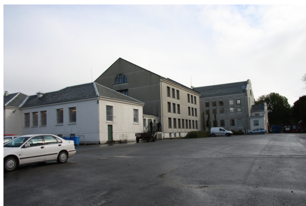
Kjøkkendelen, b-fløyen og hovedinngangen. Opphavsrett: Statsbygg.
