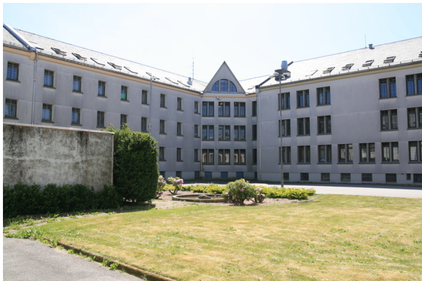
C-fløyen til venstre og B-fløyen til høyre. Sentralhall i midten. Fasader ut mot luftegården, dvs. mot nordvest. Gård for individuell lufting til venstre i bildet. Opphavsrett: Statsbygg.
