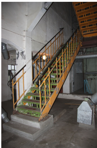
Trapp i silotårnet. Opphavsrett: Statsbygg.
