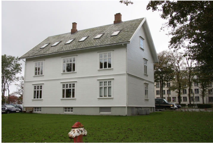
Fasaden mot sør. Hovedbygningen er i bakgrunnen og en av de mange brannhydrantene på Åna i forgrunnen. Opphavsrett: Statsbygg.
