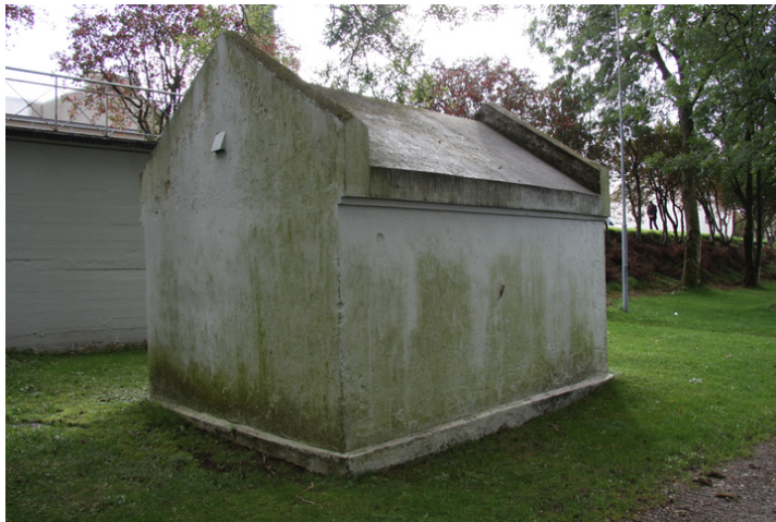
Bensinhuset. Hovedbygningen i bakgrunnen. Opphavsrett: Statsbygg.
