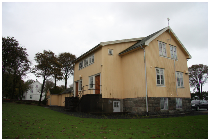
Fasadene mot vest. Husene i Hvitgata sees i bakgrunnen. Opphavsrett: Statsbygg.
