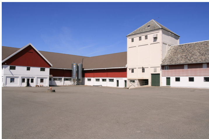
Kornsilo med fasade mot sør. Fjøs med fasade mot øst. Kornsiloen skiller ny og gammel del. Opphavsrett: Statsbygg.
