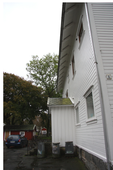
Kledningen er stort sett skiftet ut, men var også opprinnelig liggende og hvitmalt. Opphavsrett: Statsbygg.
