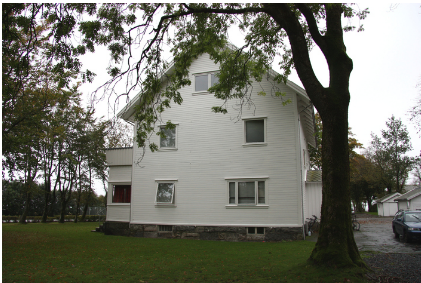
Nyere vinduer i nær hele bygningen. Opphavsrett: Statsbygg.
