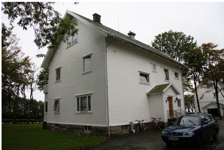
Hvitgata 1 var opprinnelig direktørbolig. Brukes i dag som hybler for aspiranter. Opphavsrett: Statsbygg.
