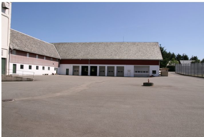
Stall og vognskjul. Fasade mot øst. Opphavsrett: Statsbygg.
