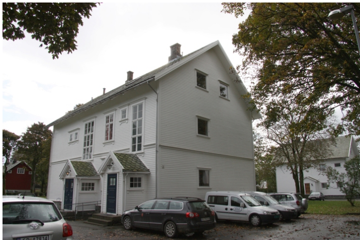
Her var det opprinnelig bolig for to funksjonærfamilier, men s det i dag er gjort om til kontorer. Opphavsrett: Statsbygg.
