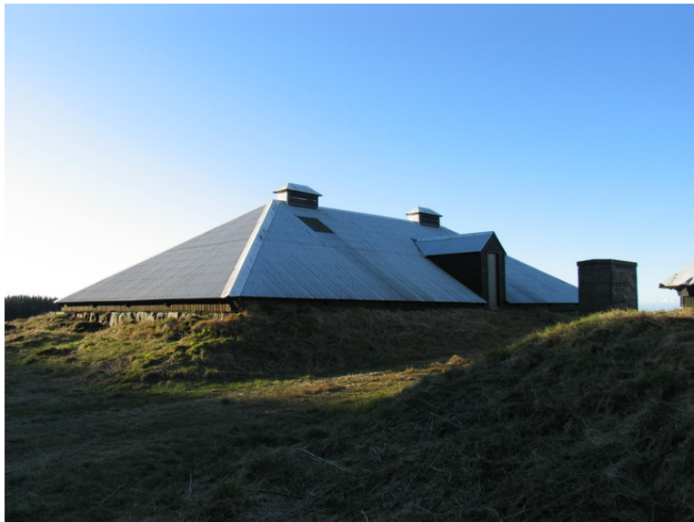
Ett av to identiske vannbasseng som ligger side om side. Opphavsrett: Kriminalomsorgen.
