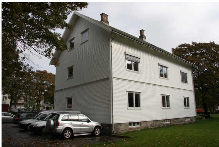
Fasadene mot sør og vest. Opphavsrett: Statsbygg.
