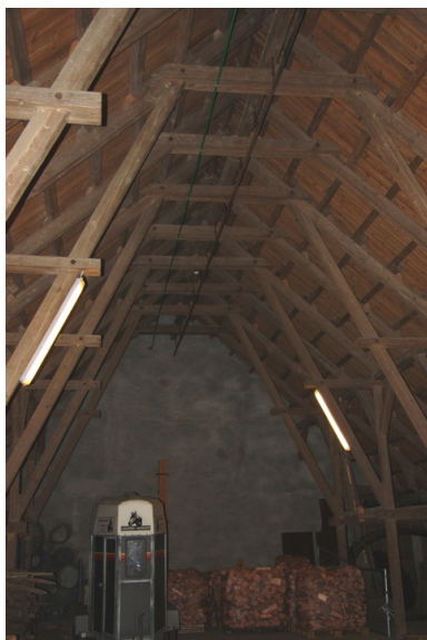
Takkonstruksjonen i låven. Opphavsrett: Statsbygg.
