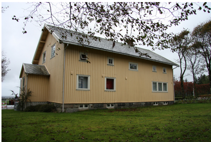
Fasaden er noe endret fra det opprinnelige, både med tanke på kledning, vindusplassering og hovedinngang. Opphavsrett: Statsbygg.
