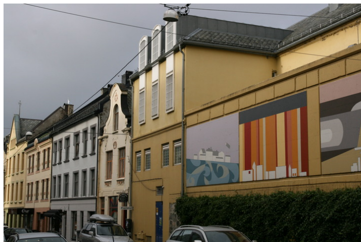
Fengslet er utbygget med en mindre fløy med celler i 2. og 3. etasje. Sett fra Kipervikgata. Opphavsrett: Statsbygg.
