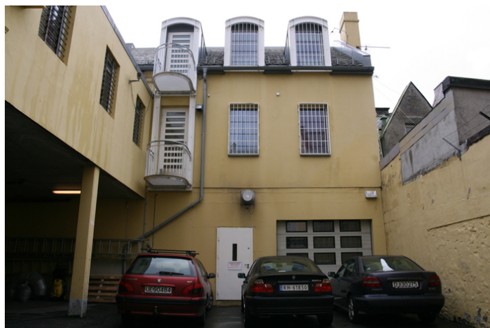
Påbygget med mekanisk verksted i 1. etasje og celler i 2. og 3. etasje. Opphavsrett: Statsbygg.
