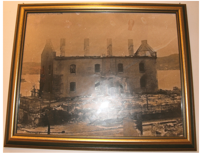
Cellefløyen etter bybrannen i 1904. Den nye fløyen ble oppført på de opprinnelige murveggene og etasjeskillet. Opphavsrett: Kriminalomsorgen.
