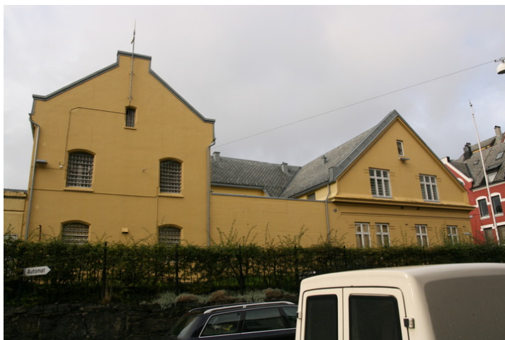
Ålesund fengsels fasade mot øst. Opphavsrett: Statsbygg.
