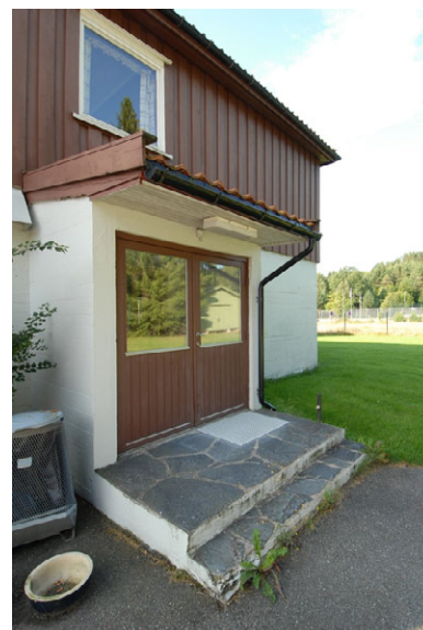
Vindfang mot spisesal. Foto: Leif Anker
