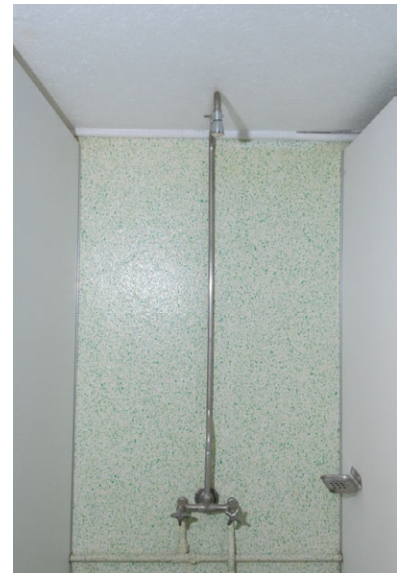
Mulig opprinnelig dusj. Foto: Leif Anker.
