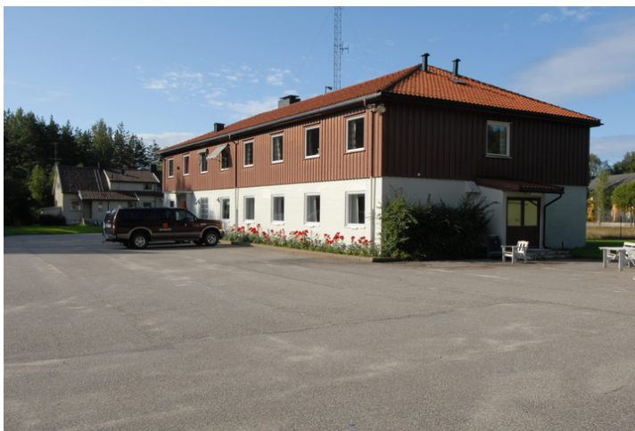
Bygget sett fra N. Foto: Leif Anker.
