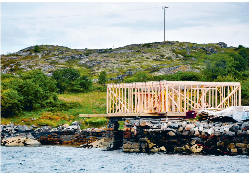
Bygging i strandsonen. Foto: Marianne Gjorv
