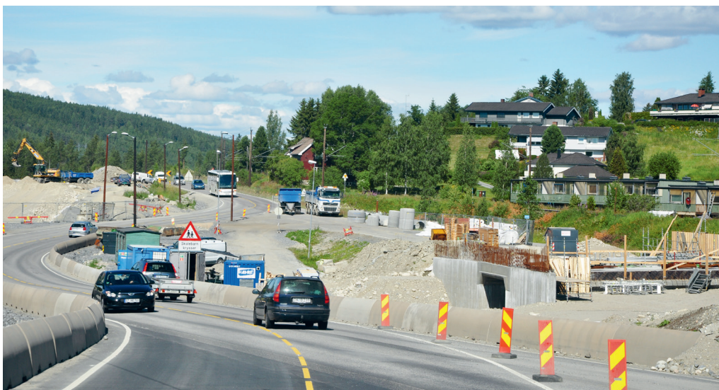
Vegbygging. Foto: Marianne Gjorv
