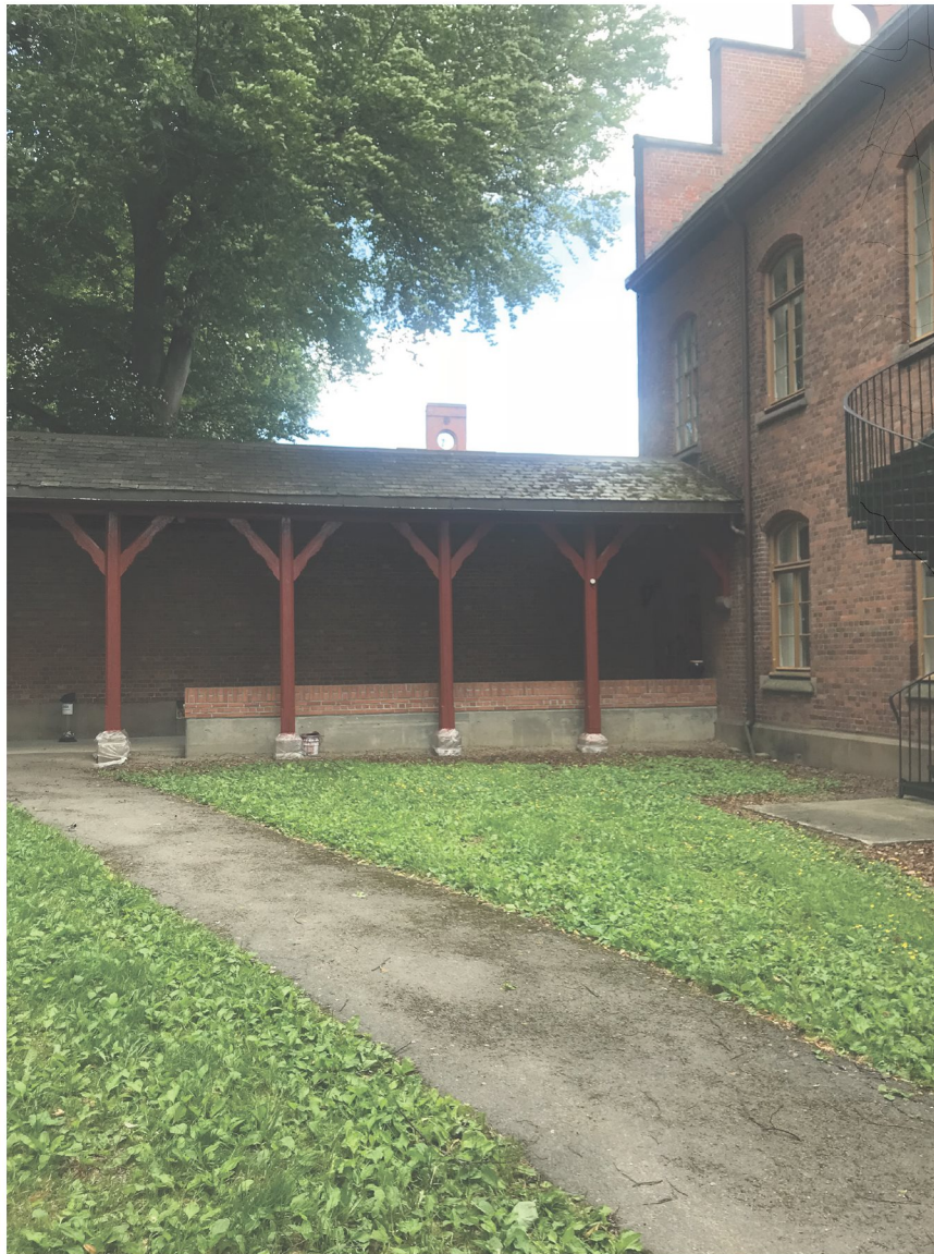
A Svalgang bygg 01, sett fra hagen. Nyere mur langs rampe for trinnfri adkomst.
