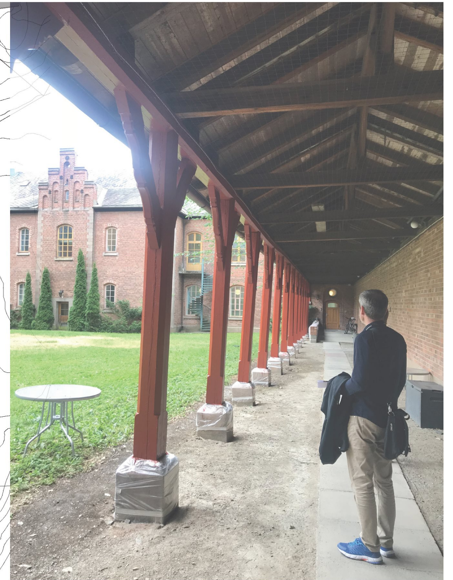
B Svalgang bygg 02, sett mot rampe for trinnfri adkomst.
