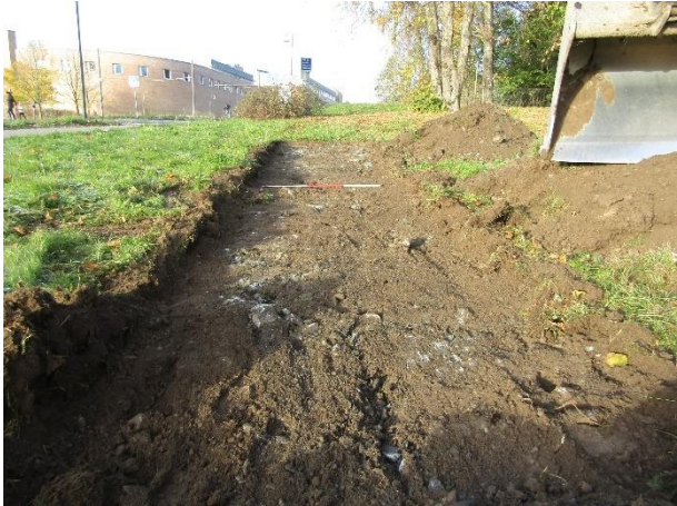
Figur 19. Schakt 29 med sten och stenflisor över berg. Foto mot V av S, Pettersson.
