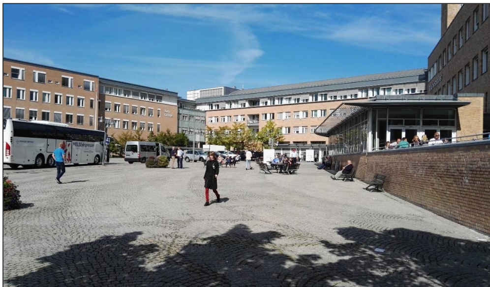
Figur 12. Atkomsttorg på Rikshospitalet sett fra sør på torget (himmelretning: mot nord).
