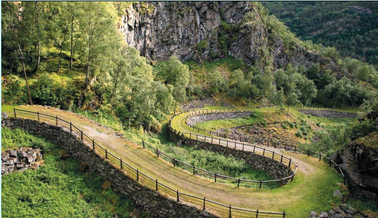
Figur 4.5 Vindhellaveien: Et av de mest kjente partiene på Kongevegen over Filefjell.
