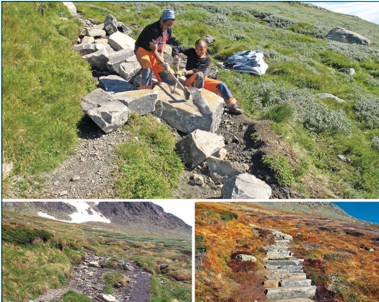
Figur 4.11 Sherpaer i arbeid. Steinsetting av stier. Bildene under viser før og etter.
