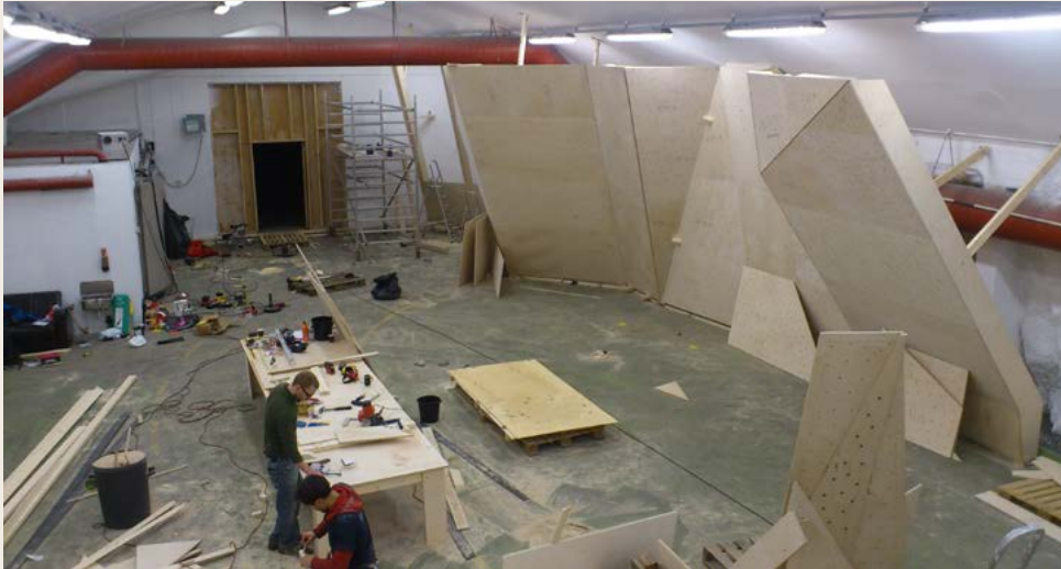
Bryggeriet buldresenter i Bergen under bygging. Foto: Erlend Sunde
