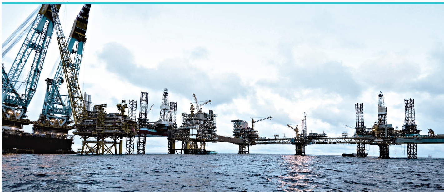
Dan F centeret med Dan FA, Dan FB, Dan FC, Dan FD, Dan FE, Dan FF, FG og med bromodulet mellem Dan FA og Dan FE. Der ses en borerig samt en vagtbåd ved Dan FF og ved Dan FA. Til venstre for Dan FG ses kranen som løftede Dan FG på plads.
