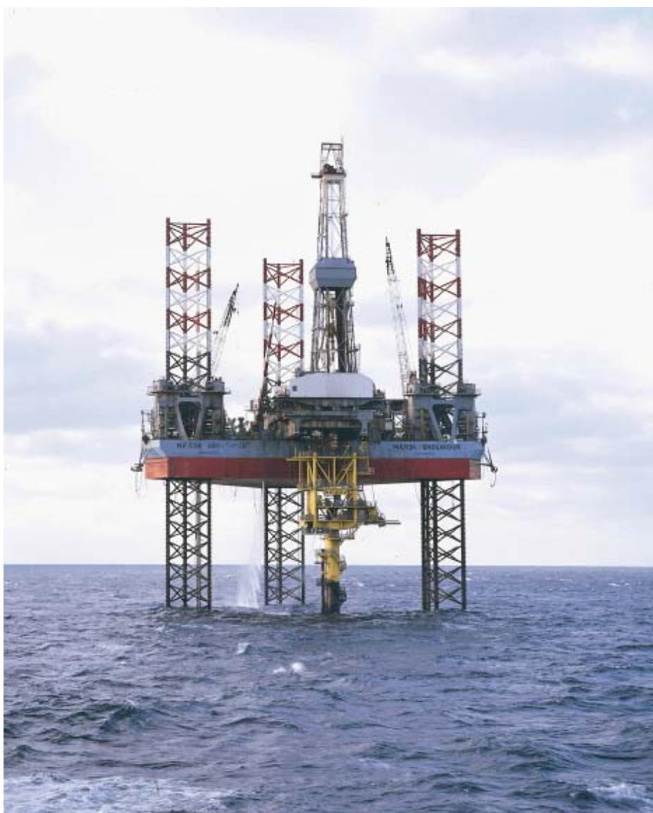
Figur 4.2 Typisk jack-up borerig (Mærsk Endeavour), ved Kraka STAR platformen
