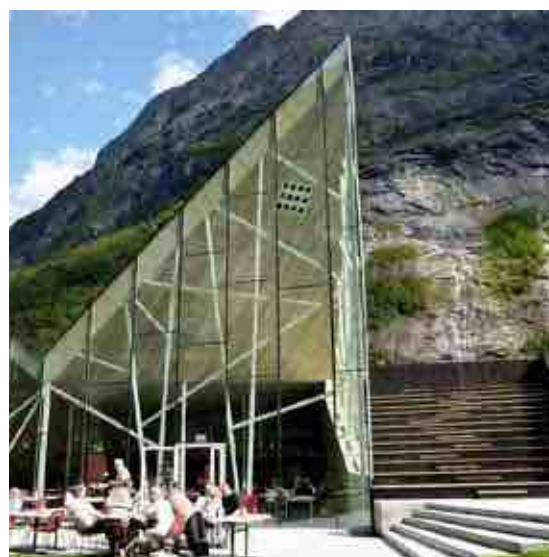
Trollveggen, Andalsnes (integrert bygning)
