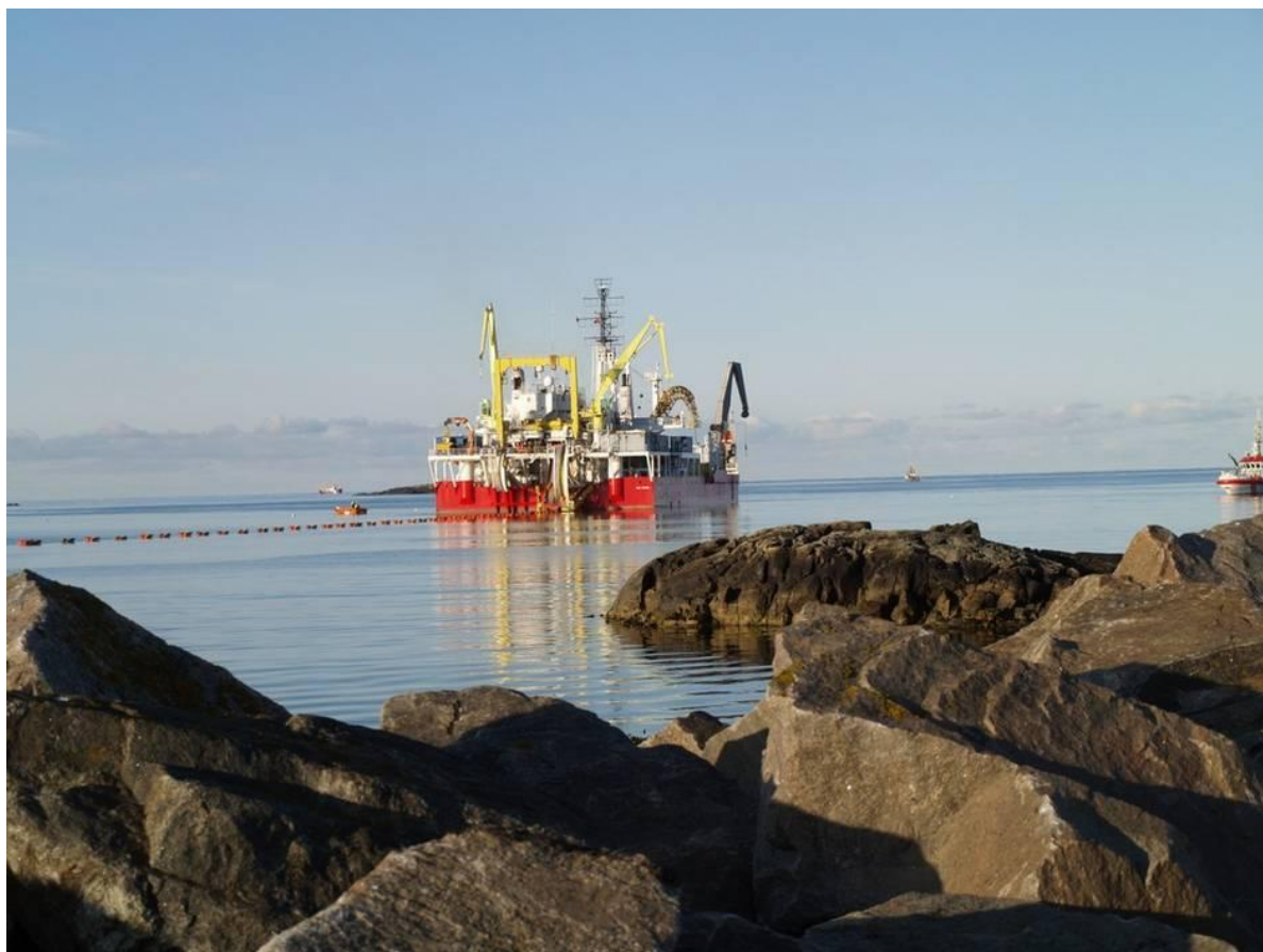
Figur 3-15 Kabelleggingsfartøy (Foto: NEXANS)
