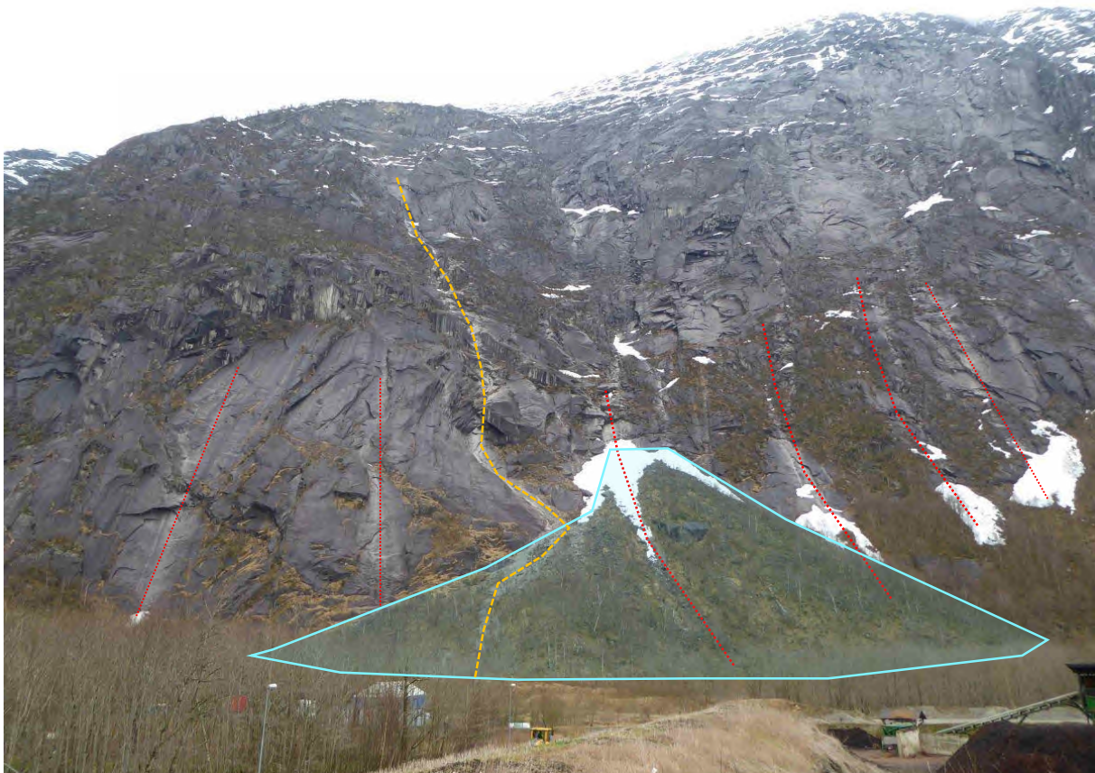
Figur 5: Oversiktsfoto som viser sørlege del av stasjonsområdet, samt fjellsida ovanfor. Ur/skredvifte er vist med blått. Registrerte skredbaner er merka med raud stipla linje, oransje markering viser ferskt steinsprang/lausmasseskred som har nådd ned til veien.
