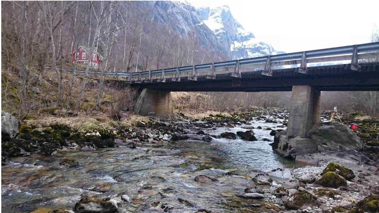
Figur 6 Øvre bro sett fra nedstrøms mot oppstrøms
