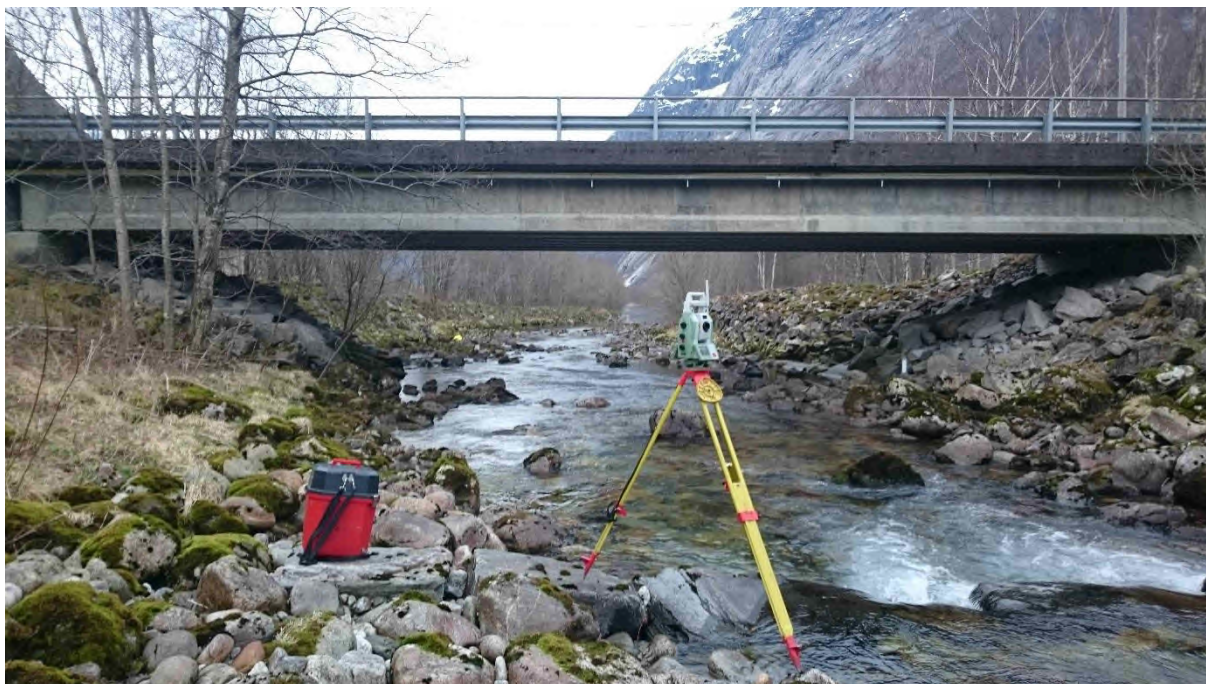
Figur 5 Nedre bro sett fra oppstrøms mot nedstrøms
