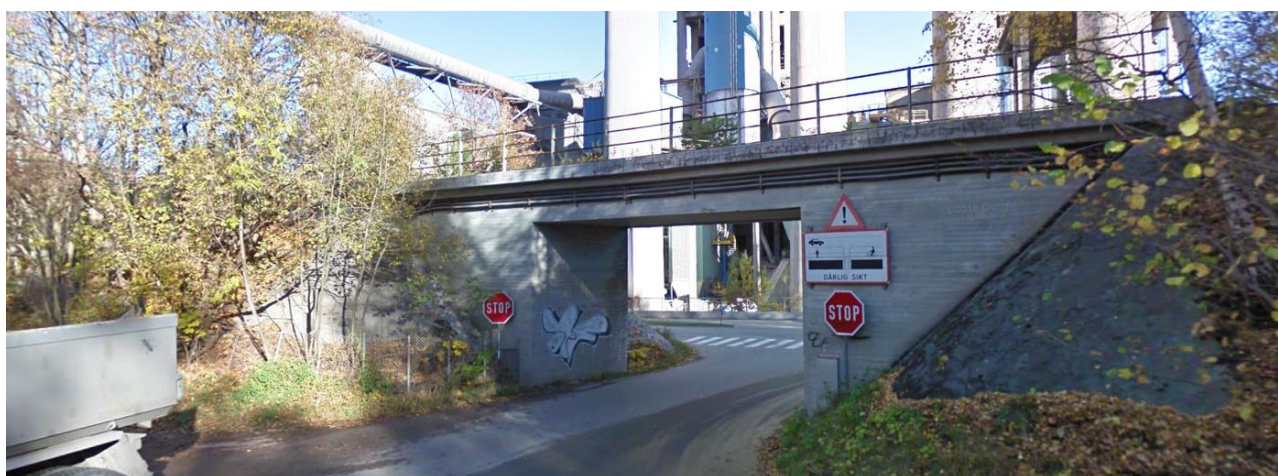
Figur 3: Kryss Hillsveg/Breviksvegen sett mot øst. Kilde: Google.
