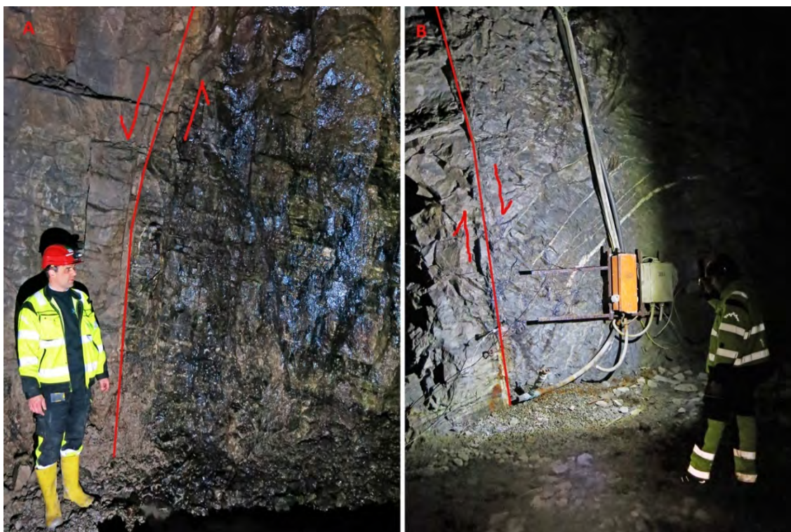
Figur 35 Venstre bilde: Eksempel på forkastning med noe innlekkasje fra -263N. Høyre bilde: Forkastning uten assosiert innlekkasje på -138S. I begge eksemplene er bergarter fra hhv Steinvikformasjonen og Fossumformasjonen sidestilt, og røde piler viser relativ bevegelsesretning. (Rambøll, 2016)
