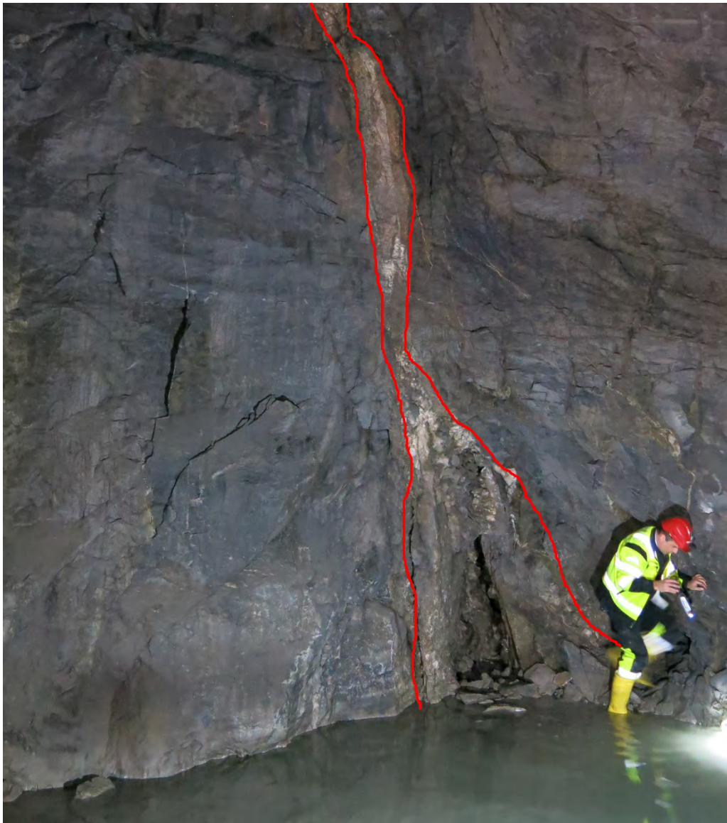
Figur 19 Bilde som viser opptreden av et åpnet og krystallfylt druserom i forlengelsen av en ellers tett kalkspatåre i Dalen gruve. Vannet kommer fra driften i gruva og har, som man kan se fra de tørre veggene, ingen tilknytning til druserommet (Foto: Rambøll Norge AS).
