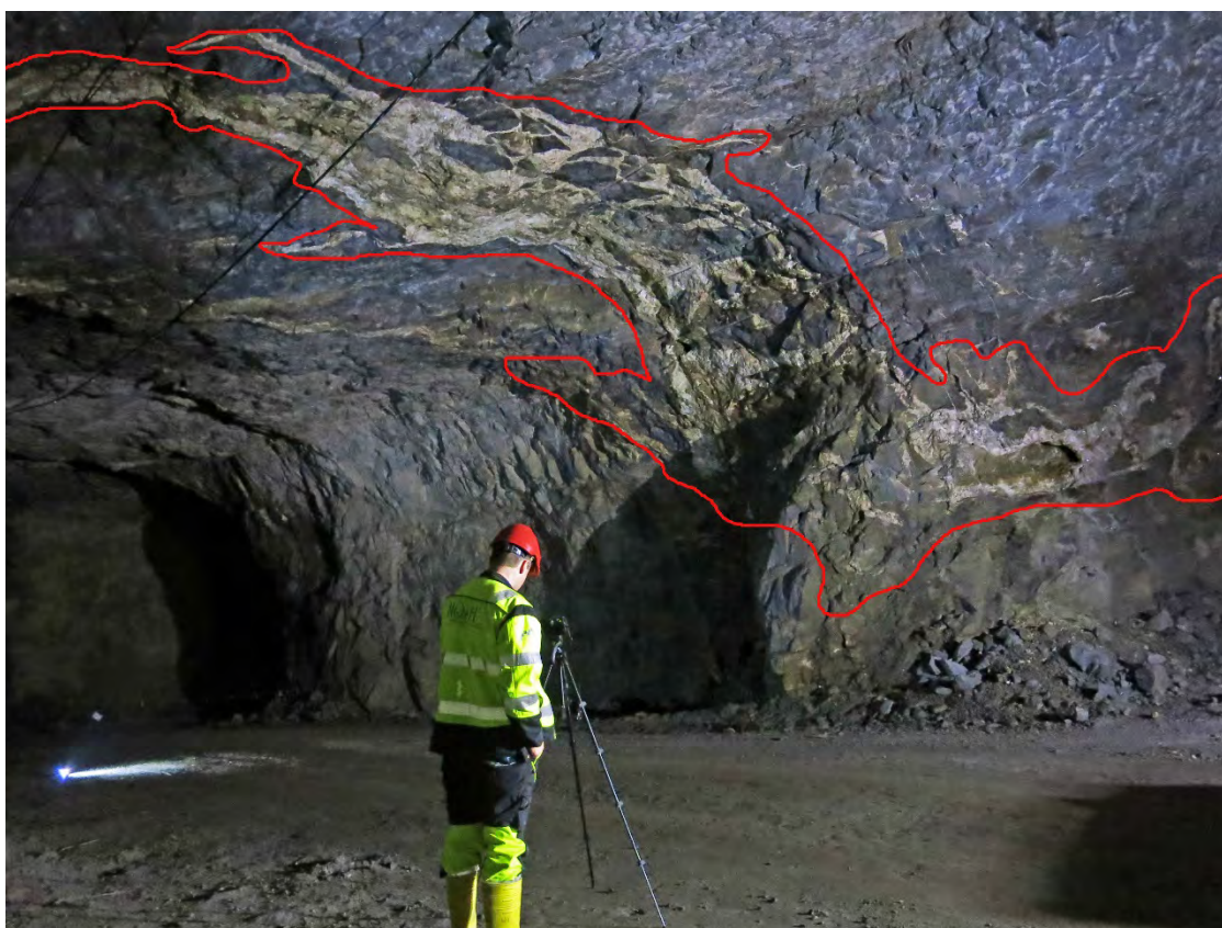
Figur 16 Bilde som illustrerer en sprekkesone som er tett som en følge av kalsittsmentering langs sprekker og forkastningssone (Foto: Rambøll Norge AS).
