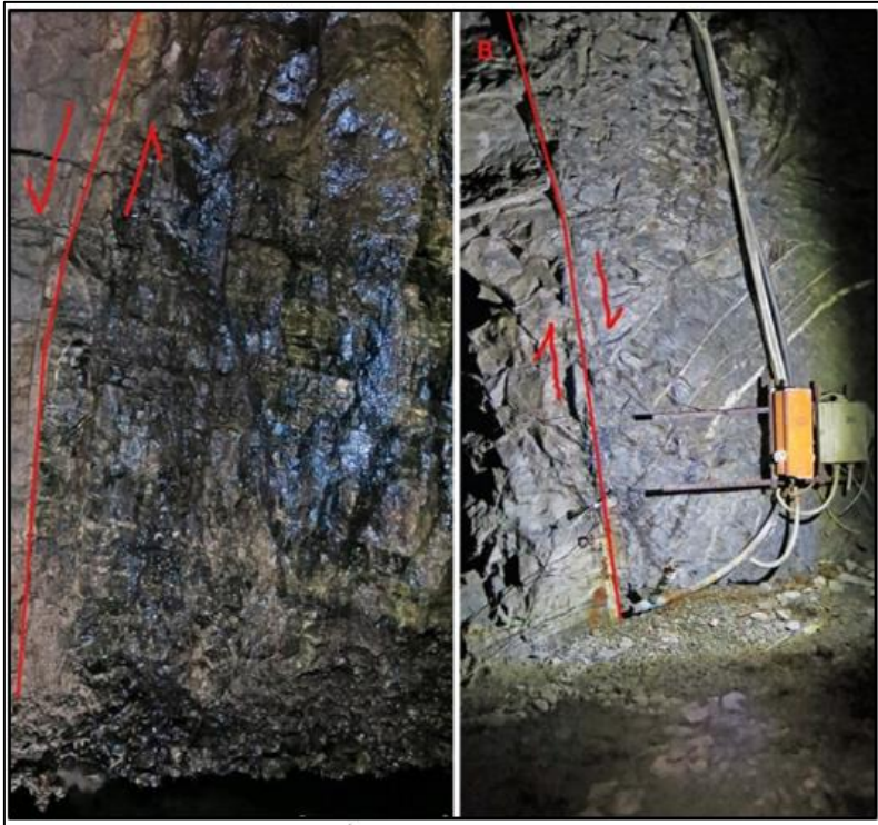
Figur 6-9: Venstre bilde: Eksempel på forkastning med noe innlekkasje fra -263N. Høyre bilde: Forkastning uten assosiert innlekkasje på -138S. I begge eksemplene er bergarter fra hhv Steinvikaformasjonen og Fossumformasjonen sidestilt, og røde piler viser relativ bevegelsesretning. (Rambøll, 2016)
