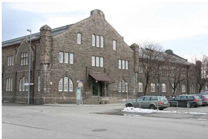
T.v. sydvestre gavlvegg i nordre pakkhusfløy med ny hovedinngang 2002 til utleiekontorene oppe i etasjene. T.h. søndre pakkhusfløy. Foto: J. Chr. Eldal, NIKU 2008.
