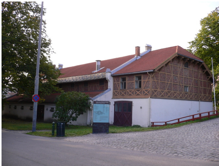
Stall og kontor. Opphavsrett: Statsbygg.
