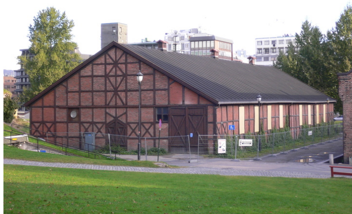
Sørfasade ridehall. Opphavsrett: Statsbygg.
