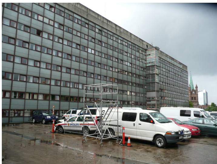
Politihusets nordfasade. Karnapp fra 2.-7. etg. Opphavsrett: Statsbygg.
