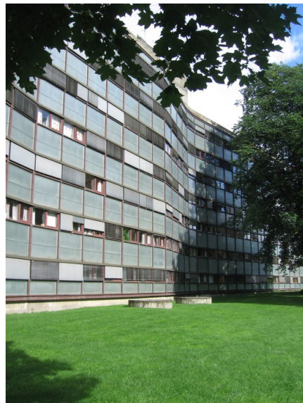
Sørfasade mot park. Registrert stor alm med biologisk mangfold til høyre. Opphavsrett: Statsbygg.
