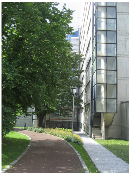
Nyanlagt parkanlegg med gangvei mellom politihus og botsfengsel. Rømningstrapper fra politihus. Opphavsrett: Statsbygg.
