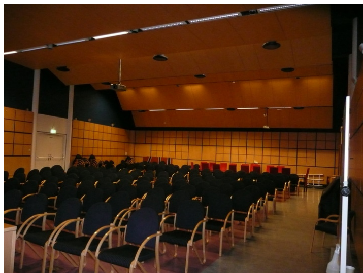
Parolesal med opprinnelig akustisk himling og veggplater. Opphavsrett: Statsbygg.
