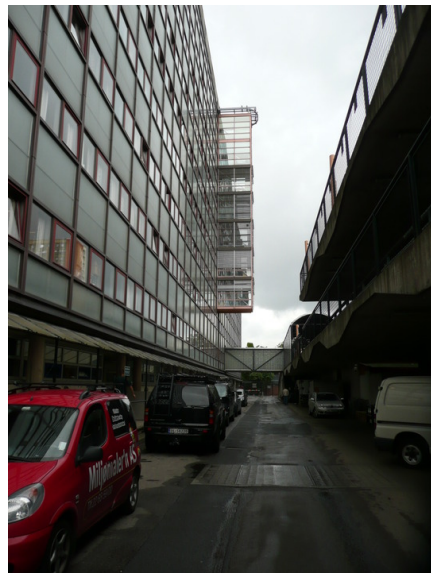
Indre vei. Gangbro mellom politihus og arrest/garasje. Opphavsrett: Statsbygg.
