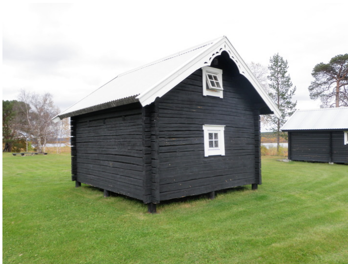
Stabbur sett fra sør. Ny badstu til høyre. Opphavsrett: Politiet.
