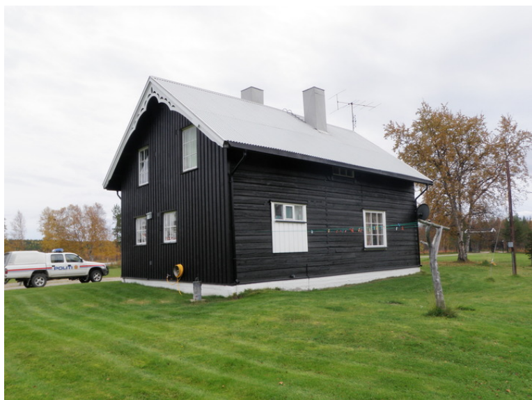
Våningshusets nordvestfasade i 2009. Opphavsrett: Politiet.
