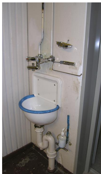
Kjellerinteriør, utslagsvask. Opphavsrett: Statsbygg.
