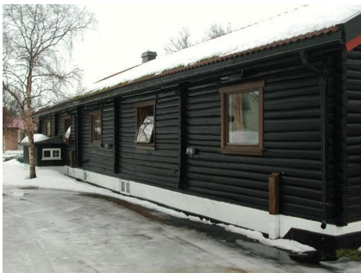
Oversiktsbilde med nordvegg. Opphavsrett: Statsbygg.
