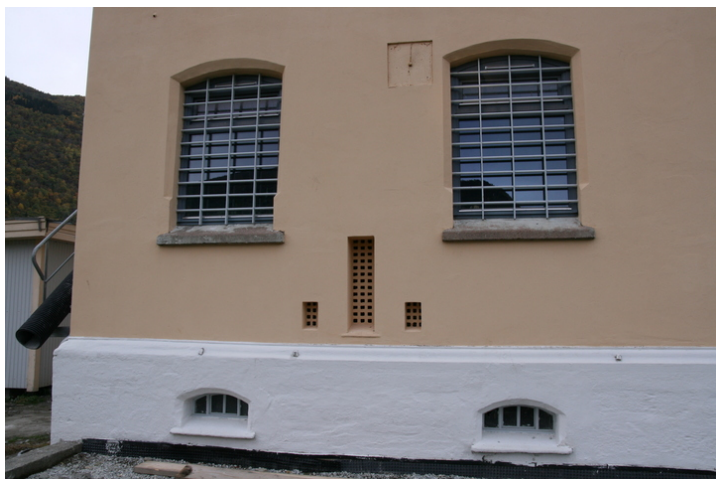
Detalj, yttervegg cellebygning: ventilasjonsluker. Opphavsrett: Statsbygg.
