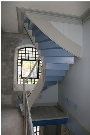
Trapp fra 2. etg til loft. Opphavsrett: Statsbygg.
