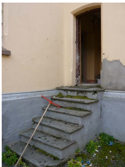
Trapp til mellomgangen fra luftegården. Opphavsrett: Statsbygg.
