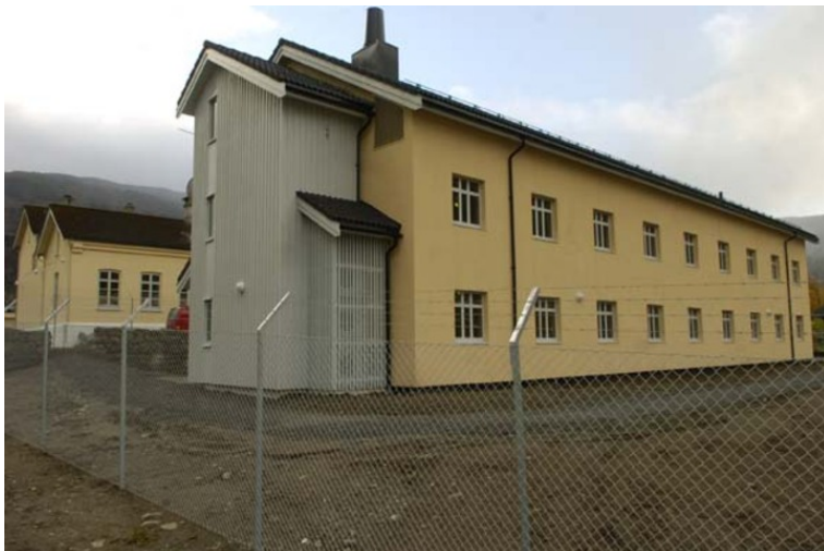
Nybygg, sett fra nordøst. I bakgrunnen forbygning og cellebygning. Opphavsrett: Kriminalomsorgen region vest.
