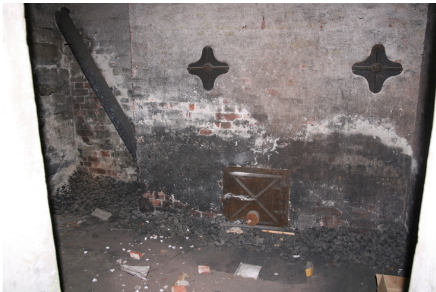
Spor av fyring i kjellerom. Opphavsrett: Statsbygg.
