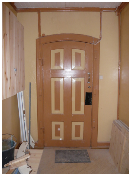
Dør i mellomgang. 2008. Opphavsrett: Statsbygg.
