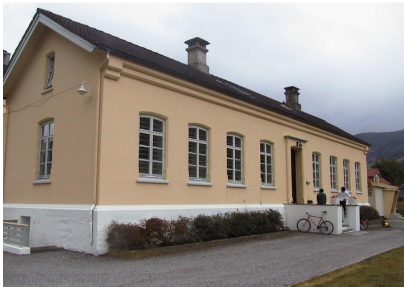
Vik fengsel - fasade Opphavsrett: Statsbygg.
