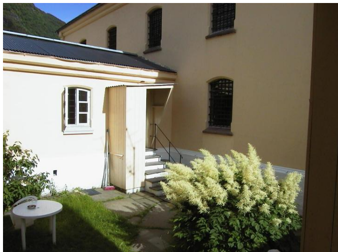
Mellombygg og kjøkkenhage. Foto: Odd Arild Skagen. Opphavsrett: Statsbygg.
