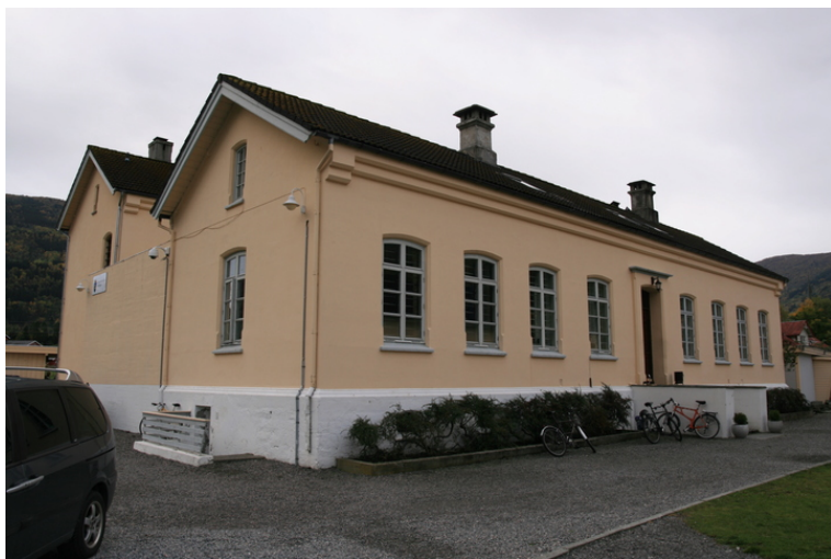
Vik fengsel. Forbygning med rettslokale og bolig i forgrunnen. Cellebygning i bakgrunnen. Lufttegård mellom (ombygget i 2009). Opphavsrett: Statsbygg.
