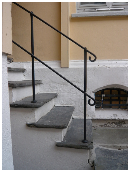
Detalj av trapp mot kjøkkenhagen. Opphavsrett: Statsbygg.
