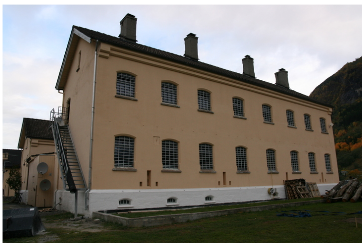
Cellebygning mot sør. Rester av mur for opprinnelig plankegjerd på bygningens sørside. Opphavsrett: Statsbygg.
