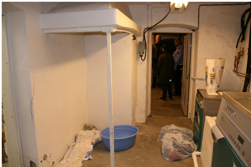
Kjeller under leiligheten. Opphavsrett: Statsbygg.
