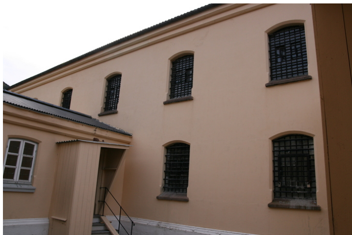
Cellebygning. Fasade mot kjøkkenhagen. Mellombygg til venstre. Opphavsrett: Statsbygg.
