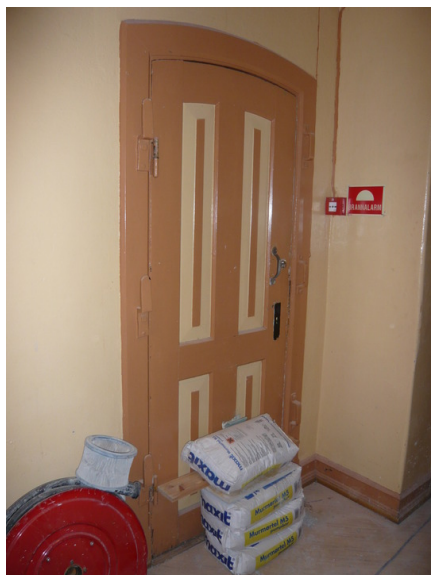
Dør i mellomgang. 2008. Opphavsrett: Statsbygg.
