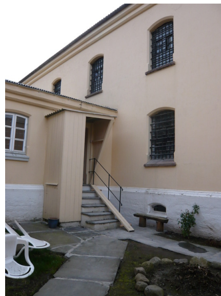
Inngangsparti mot kjøkkenhagen. Opphavsrett: Statsbygg.
