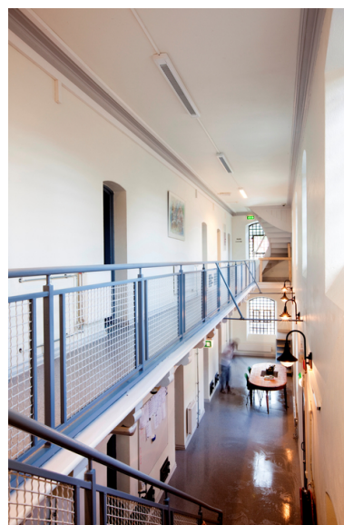
Galleri og korridor. Foto: Trond Isaksen. Opphavsrett: Statsbygg.
