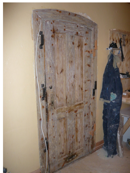
Dør i mellomgang. 2008. Opphavsrett: Statsbygg.
