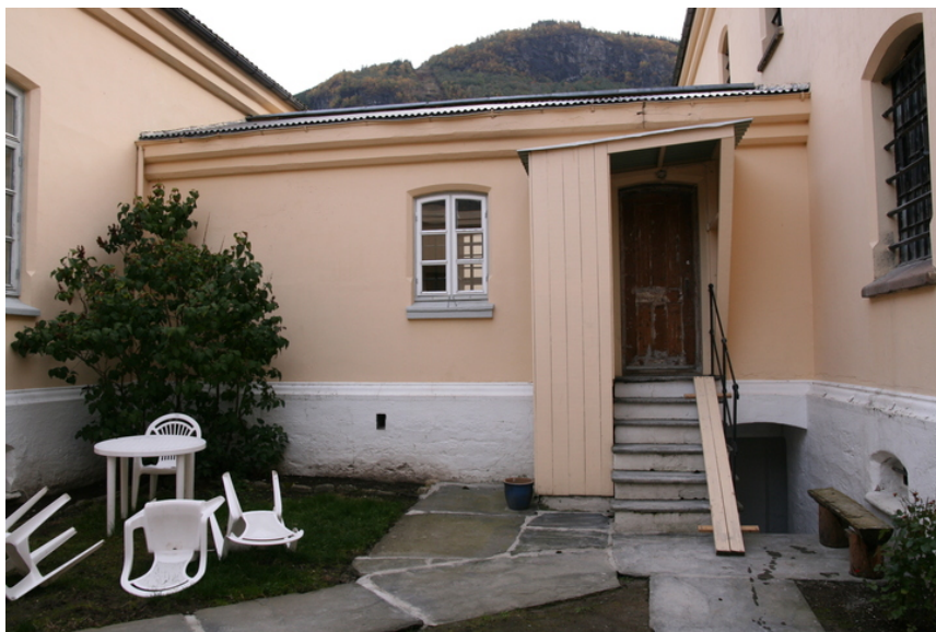
Mellomgang sett fra kjøkkenhagen. Opphavsrett: Statsbygg.
