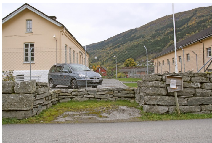
Opprinnelig adkomst til forbygning. Ny celleavdeling til høyre. Opphavsrett: Statsbygg.
