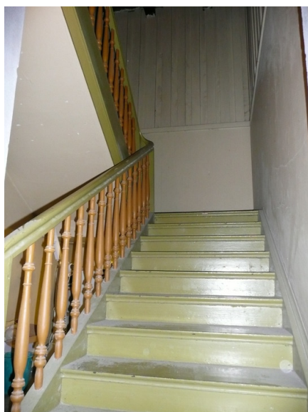
Trapp fra rettslokaler til loft. Opphavsrett: Statsbygg.
