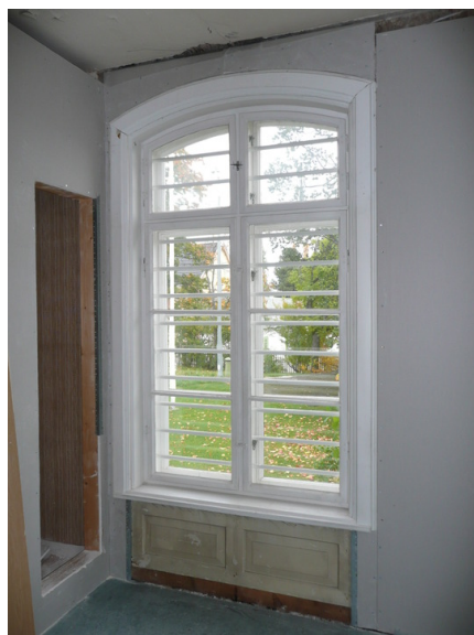
Tidligere bolig. Originalt vindu med fylling. Opphavsrett: Statsbygg.
