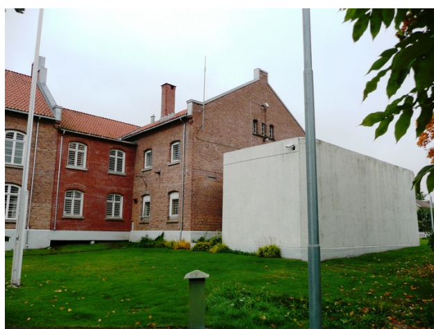
Mellomgang, cellefløy og lufttegård. Fasader mot øst og nord. Med vei til opprinnelig inngang til rettslokalet og oppheng til lampe på cellefløy. Opphavsrett: Statsbygg.
