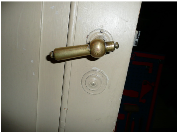
Fengsel og mellomgang. Dørhåndtak dør til loft. Opphavsrett: Statsbygg.
