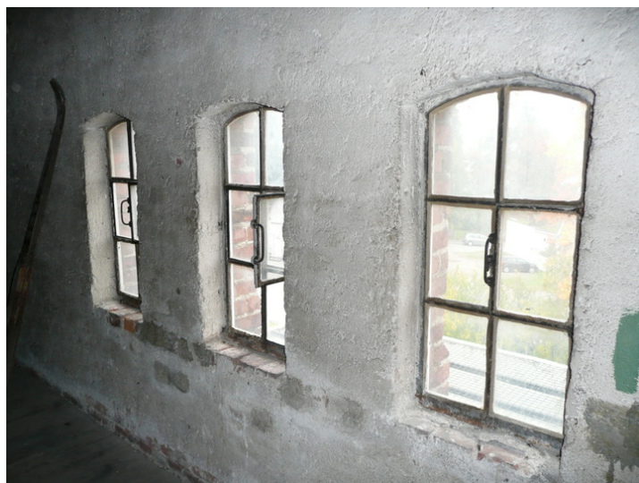
Loft. Originale vinduer. Opphavsrett: Statsbygg.
