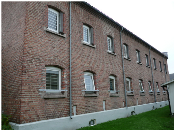
Fasade mot øst. Opphavsrett: Statsbygg.
