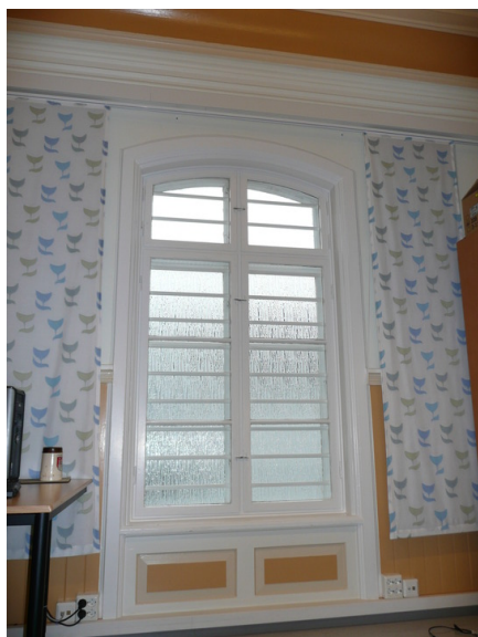
Tidligere rettsal. Originale vinduer med fyllinger. Opphavsrett: Statsbygg.
