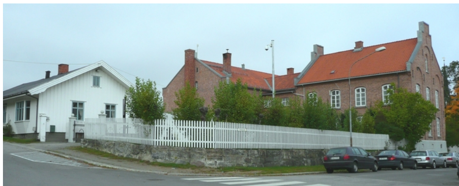
Velferdsbygg/inspektørbolig, fengsel og gammel inspektørbolig med rettslokale. Opphavsrett: Statsbygg.
