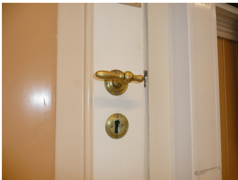
Tidligere rettsal detalj dørhåndtak. Opphavsrett: Statsbygg.
