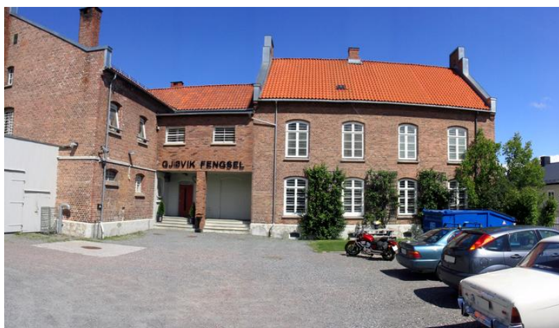
Hovedinngang, med cellefløy til venstre og rettslokal/opprinnelig inspektørbolig til høyre. Opphavsrett: Kriminalomsorgen.
