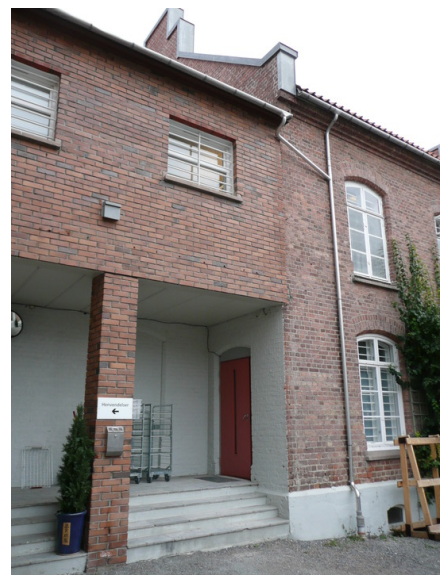
Mellomgang med hovedinngang. Opphavsrett: Statsbygg.
