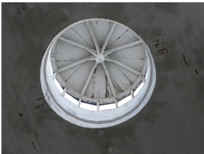
Overlys i tunnel. Opphavsrett: Statsbygg.
