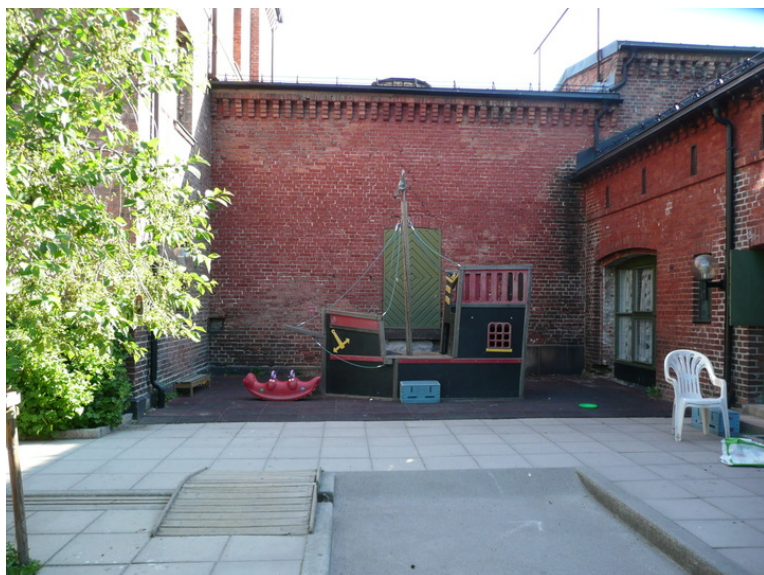
Plass foran direktørbolig, mot mellomgang. Opphavsrett: Statsbygg.
