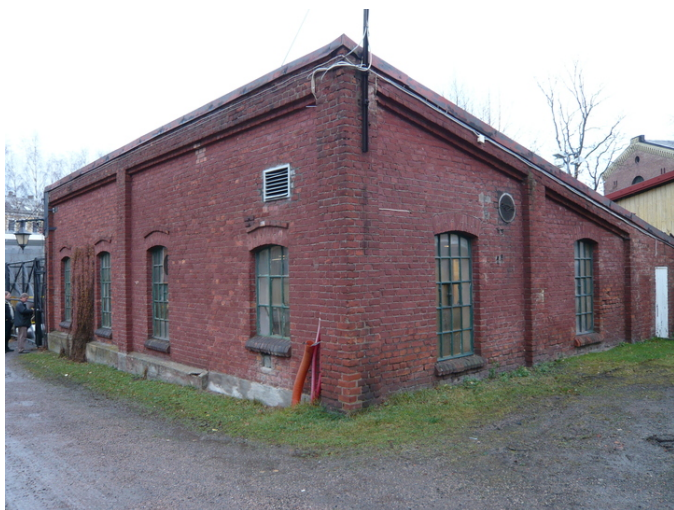
Smie sett fra nordøst. Opphavsrett: Statsbygg.
