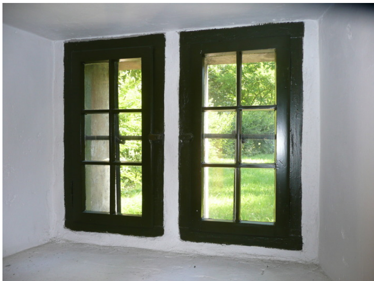
Originale vinduer i kjelleren, fengselsutsalget. Opphavsrett: Statsbygg.
