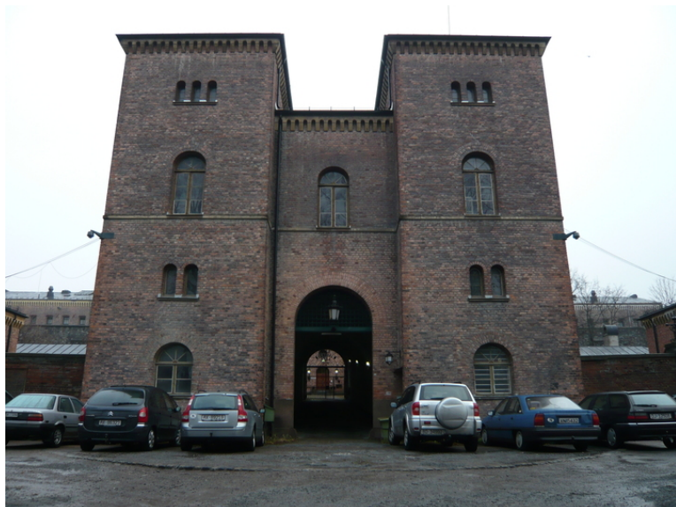
Tårnbygget er Botsfengselets hovedinngang. Opphavsrett: Statsbygg.
