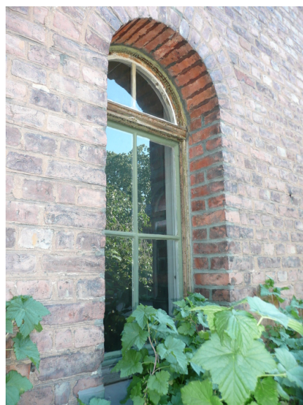
Vindu i 1. etg. Opphavsrett: Statsbygg.
