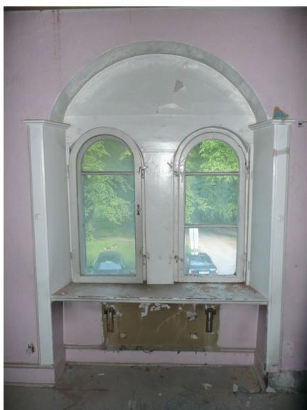
Vindu i 2. etg. mot forplassen. Opphavsrett: Statsbygg.
