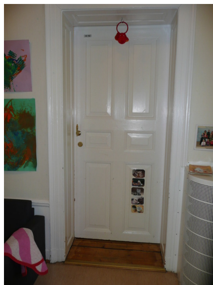
Opprinnelige dører. Opphavsrett: Statsbygg.
