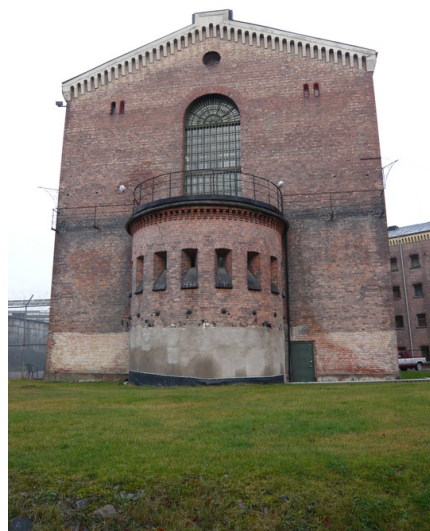
I enden av hver cellefløy var det luftestråler i vifteform for individuell lufting av innsatte. Opphavsrett: Statsbygg.
