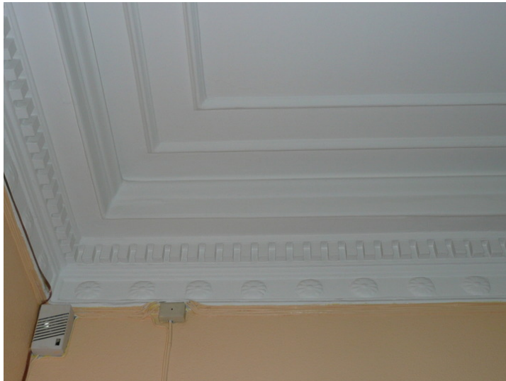
Detalj fra stue: Stukkgesims. Opphavsrett: Statsbygg.
