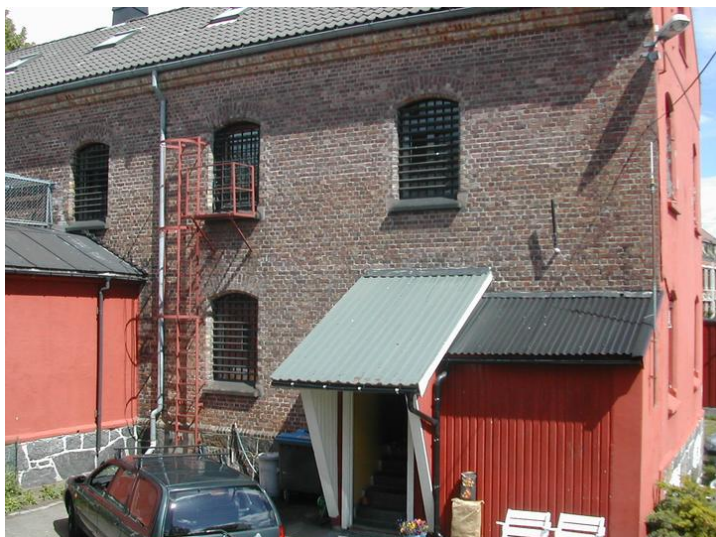
Cellebygning. Inngang fra bakgård. Mellombygg til venstre. Sett fra sørvest. Foto: Terje Weber.
