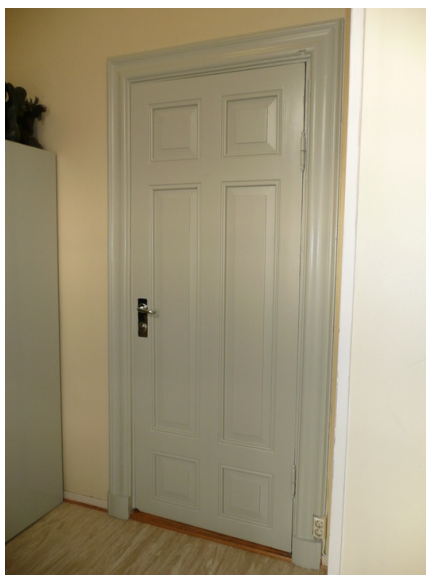
Opprinnelig dør og gerikter. Opphavsrett: statsbygg.
