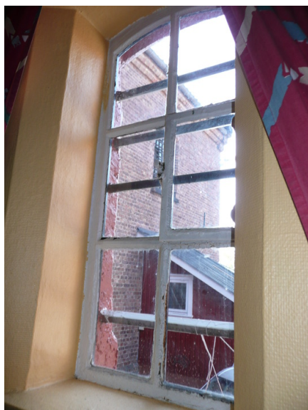
Vindu i mellombygg. Mot luftetgård. Opphavsrett: Statsbygg.
