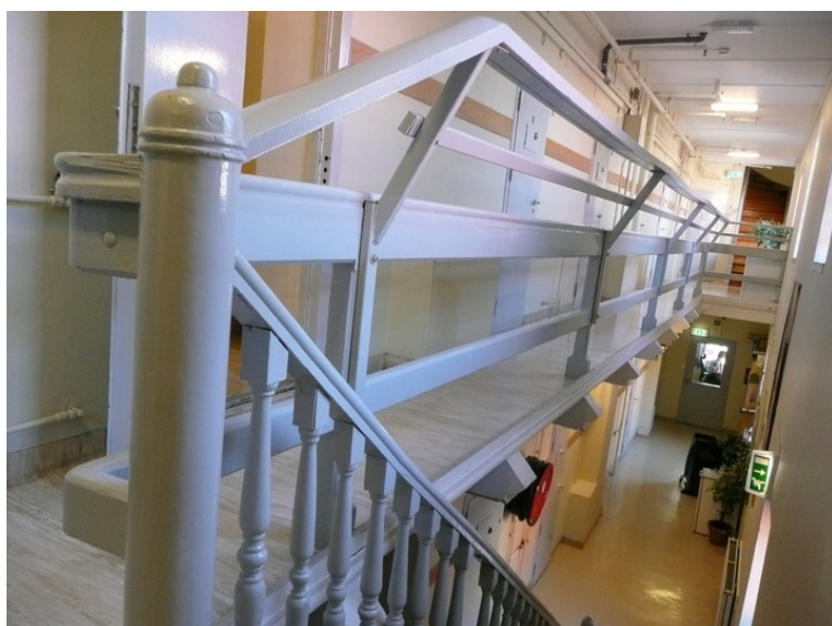
Gelender i galleri, topp av trapp. Trapp til loft sees i enden. Opphavsrett: Statsbygg.
