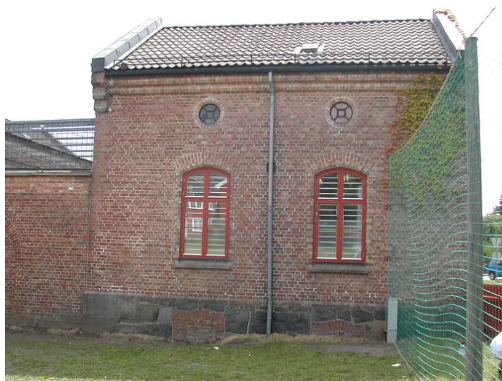
Fasade mot nord. Opphavsrett: Kriminalomsorgen.
