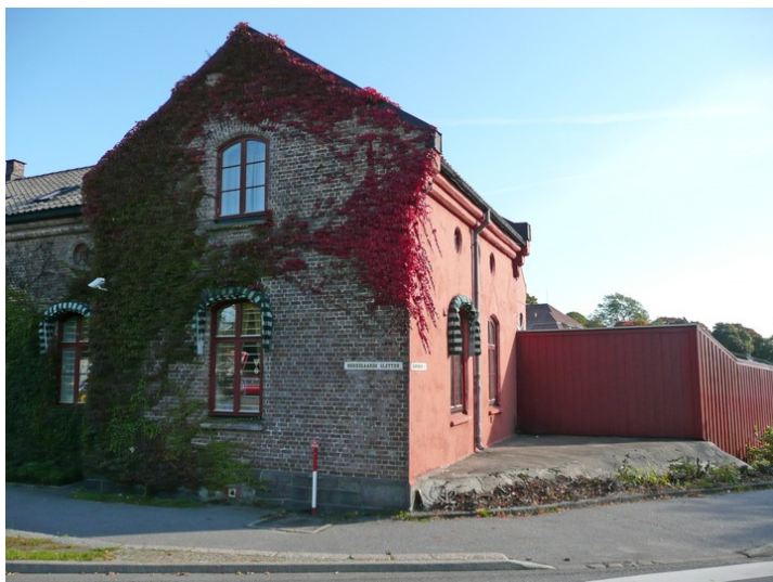
Forbygning, hjørne Herregårdssletta/Dronningensgate. Opphavsrett: Statsbygg.
