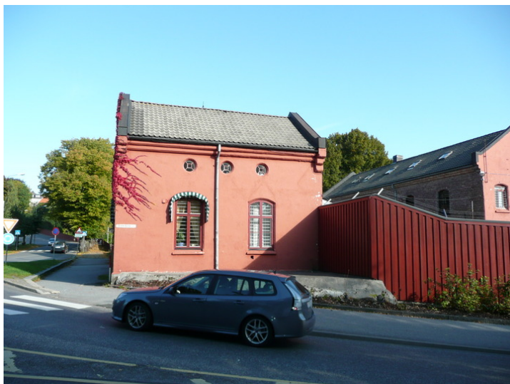
Fasade mot syd. Opphavsrett: Statsbygg.
