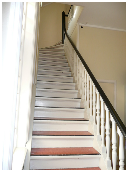
Opprinnelig trapp i forbygning. Opphavsrett: Statsbygg.
