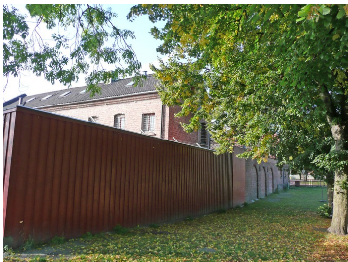
Mur mot Herregård. Sett fra nordøst. Opphavsrett: Statsbygg.
