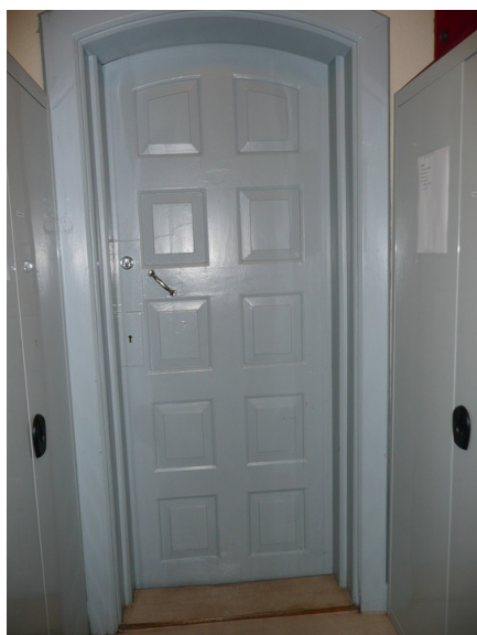
Opprinnelig dør i kontor, nå mottakelse. Opphavsrett: Statsbygg.
