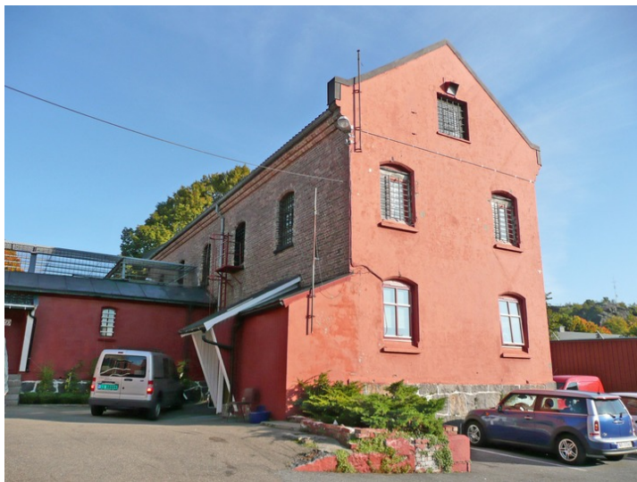
gavl mot syd, mellombygg til venstre, vaktom i 1. etg. Opphavsrett: Statsbygg.
