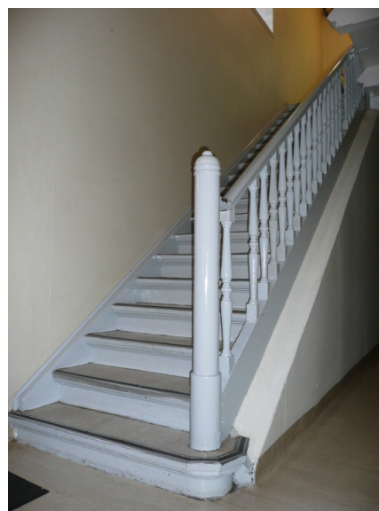
Trapp i cellefløy. Opphavsrett: Statsbygg
