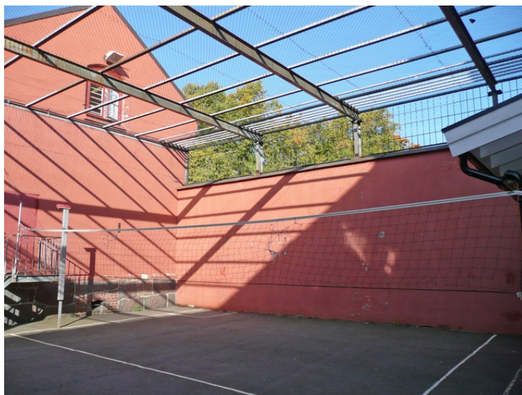
Lufttegård med Forbygning og opprinnelig mur mot nord. Opphavsrett: Statsbygg.
