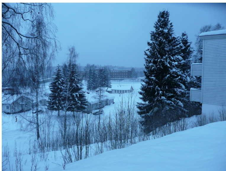
Plassering av direktørbolig speiler sosialt hierarki. Fra direktørboligen er det god oversikt over fengselsområdet mens funksjonærboligene (til høyre i bilde) ligger nærmere skogbrynet. Opphavsrett: Statsbygg.
