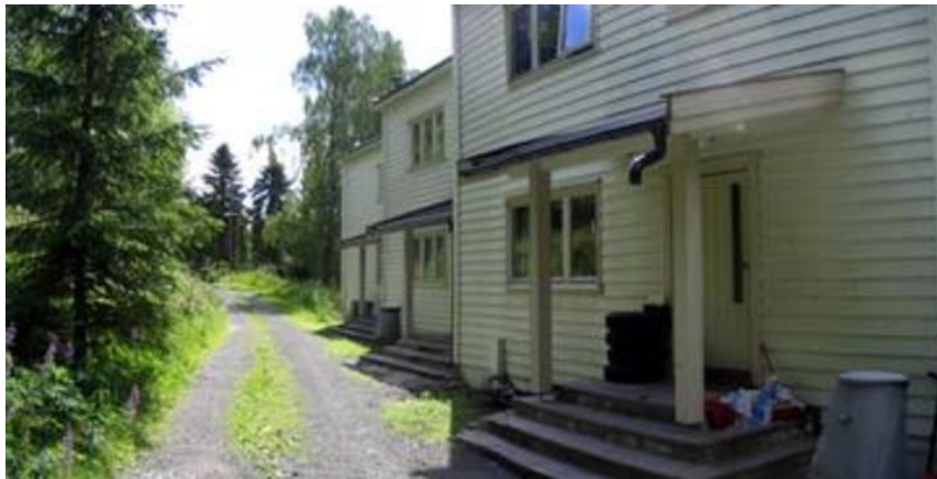
Inngang Casino. Fasade mot nord. Opphavsrett: Kriminalomsorgen.
