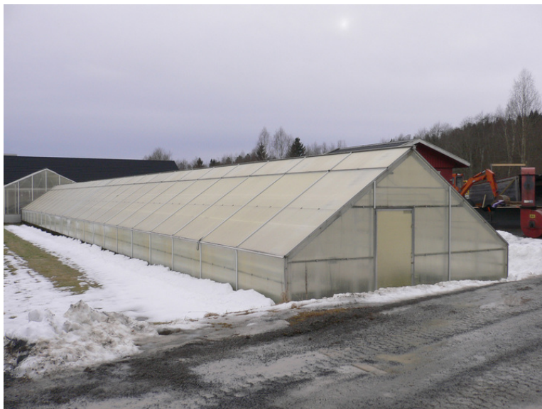
Drivhuset med fasade mot nordøst. Opphavsrett: Statsbygg.
