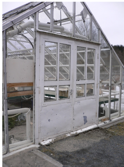
Detalj fra drivhus lengst mot vest Opphavsrett: Statsbygg.
