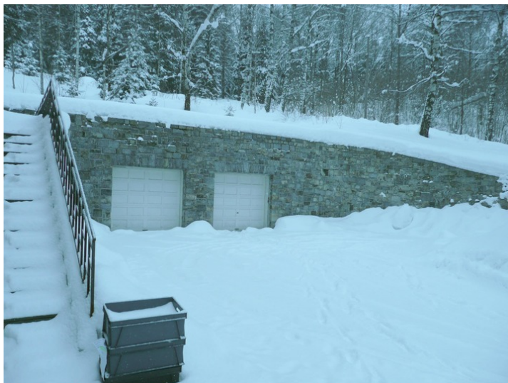
Garasjeanlegg bygd av Grinifanger under 2. verdenskrig. Opphavsrett: Statsbygg.
