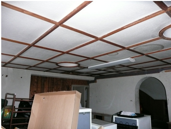
Fra casinointeriøret. Opphavsrett: Statsbygg.
