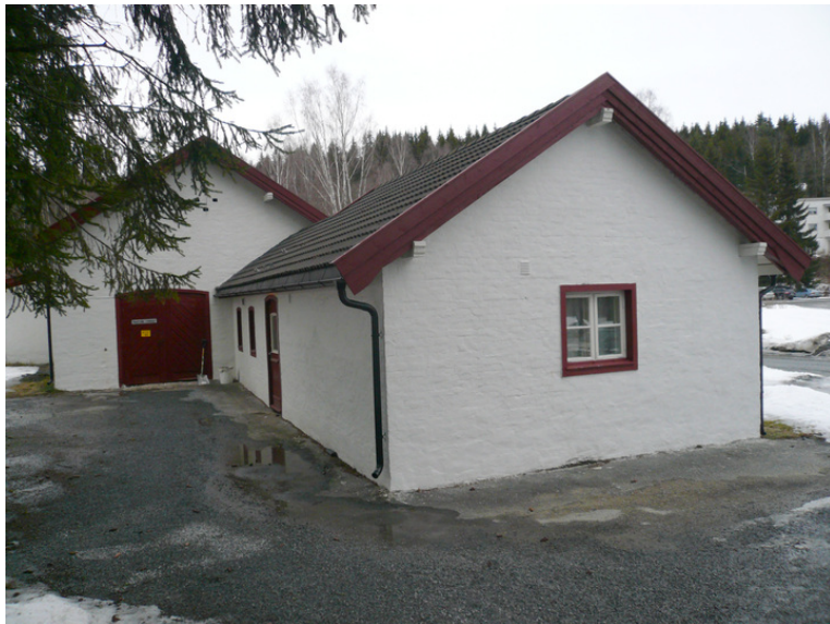
Mot sørvest. Opphavsrett: Statsbygg.
