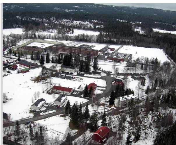
Ila fengsel - oversikt fra øst mot inngang. Opphavsrett: Kriminalomsorgen.
