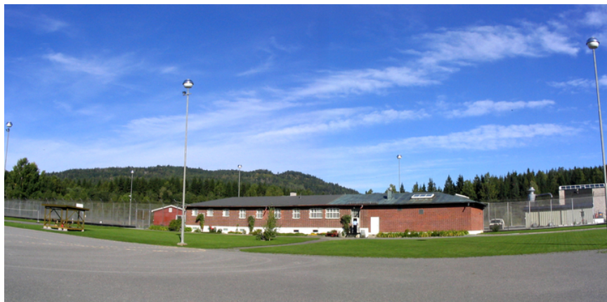
Annekset med fasade mot syd. Rødmalt tilbygg i tre mot vest, og tilbygg i tegl mot øst omfattes ikke av vernet. Opphavsrett: Kriminalomsorgen.
