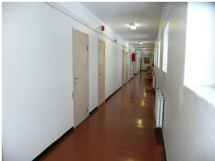
Sydfløyen i 4. etasje. Korridor med antatt opprinnelig linoleum på gulvet. Vinduer mot luftegården og dører inn til kontorer og kott. Opphavsrett: Statsbygg.
