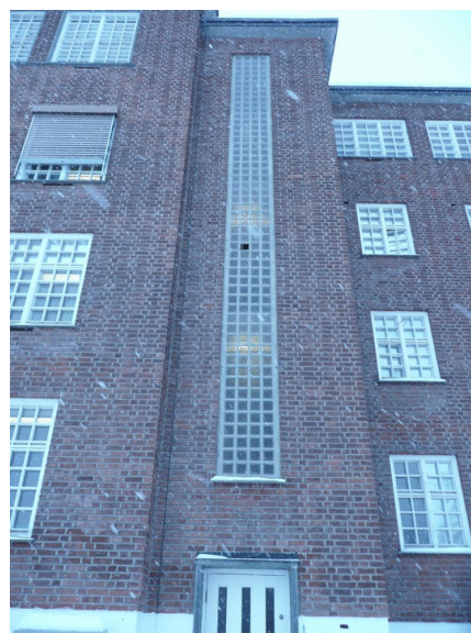
En rute i trapperommets vindu ble fjernet under krigen, angivelig et skyteskår. Østfasaden. Opphavsrett: Statsbygg.
