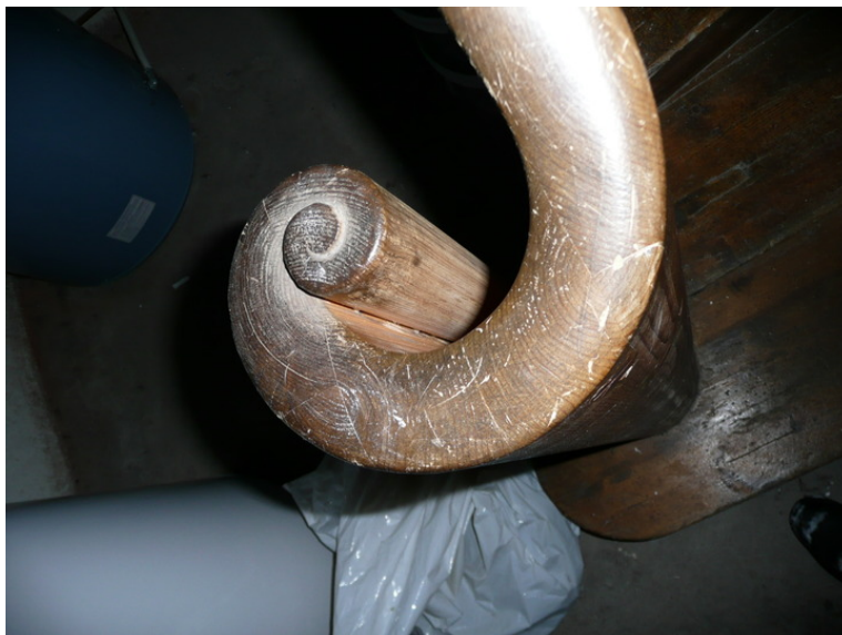
Detalj trapp. Opphavsrett: Statsbygg.
