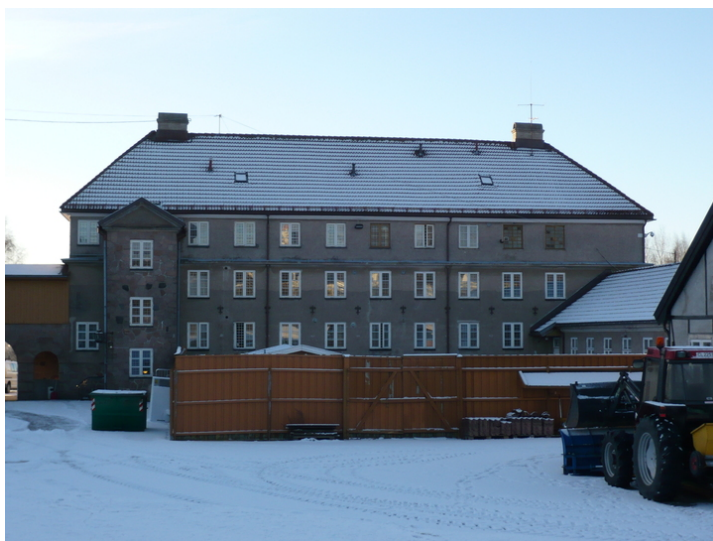
Internatbygning, nordsiden. Opphavsrett: Statsbygg.
