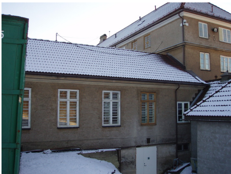
Opprinnelig snekkerverksted. I dag systue. Opphavsrett: Statsbygg.
