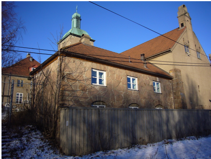
Vaskeribygningen har to etasjer. Østsiden sett fra gangveien utenfor fengselet. Opphavsrett: Statsbygg.
