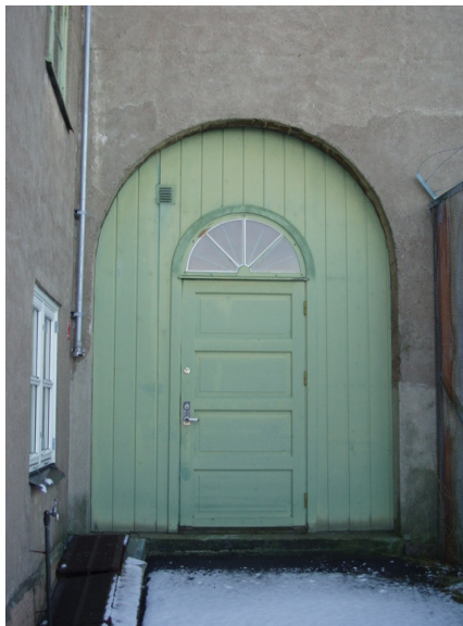
Inngang til tårnet. Nordsiden. Opphavsrett: Statsbygg.
