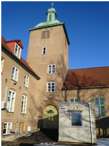
Tårnets sørside med administrasjonsbygning til venstre og kirken til høyre. Opphavsrett: Statsbygg.
