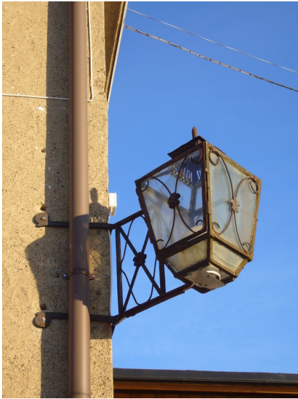
Parafinlykt på internatbygningens sørøstre hjørne. Opphavsrett: Statsbygg.
