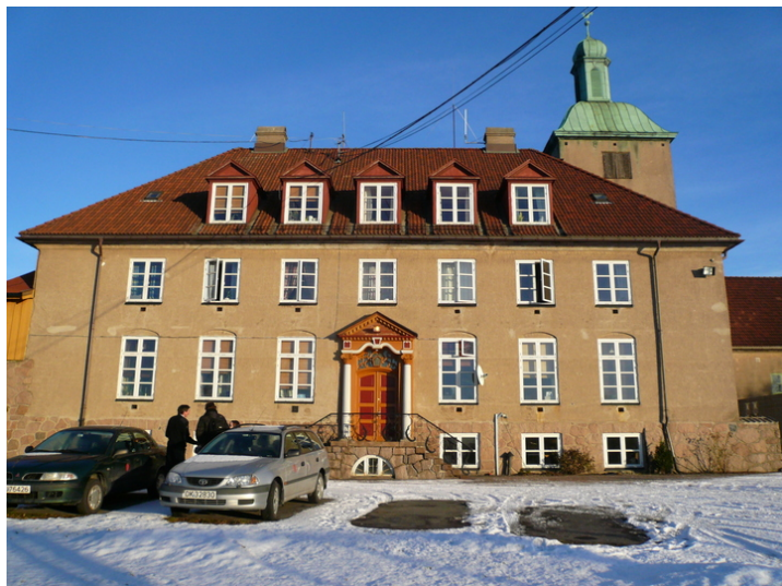
Administrasjonsbygget sørveggen Foto: LVP Statsbygg Opphavsrett: LVP Statsbygg
