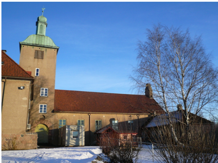
Kirken og tårnet ligger i tilknytning til administrasjonsbygningen. Sørsiden. Opphavsrett: Statsbygg.
