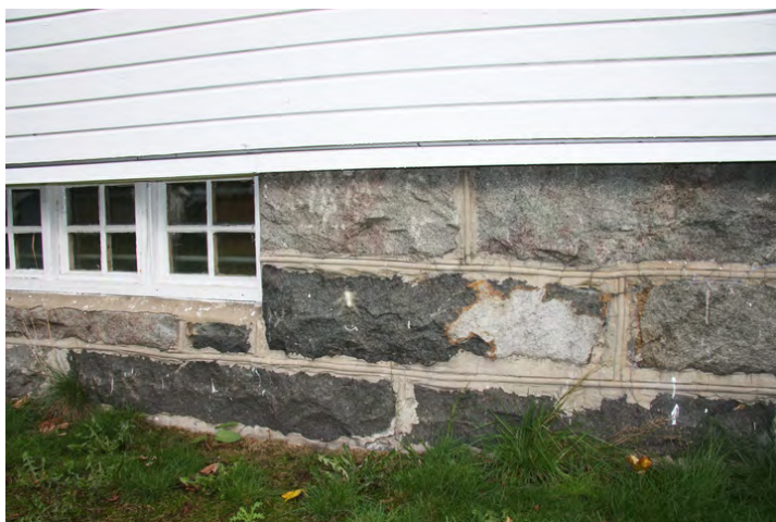
Detalj fra grunnmuren. Opphavsrett: Statsbygg.
