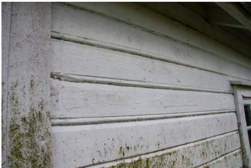
Uthuset har en blanding av nyere og eldre panel. Her er den eldre. Opphavsrett: Statsbygg.
