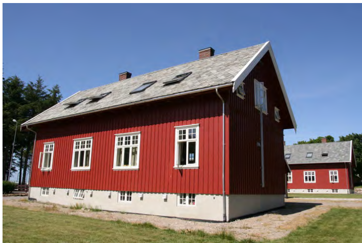
Fasader mot hagen, sør. Opphavsrett: Statsbygg.
