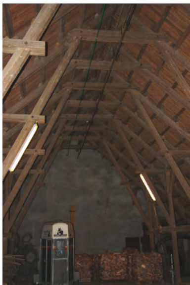
Takkonstruksjonen i låven. Opphavsrett: Statsbygg.
