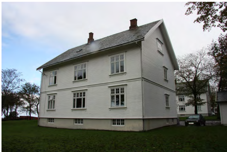
Også Hvitgata 2 har nyere kledning og vinduer. Opphavsrett: Statsbygg.
