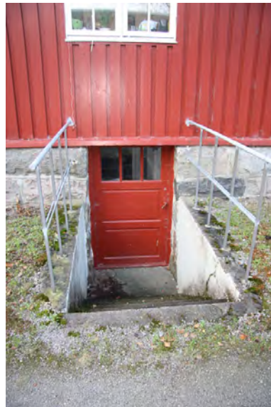
Eldre kjellerdør og nyere kledning. Opphavsrett: Statsbygg.
