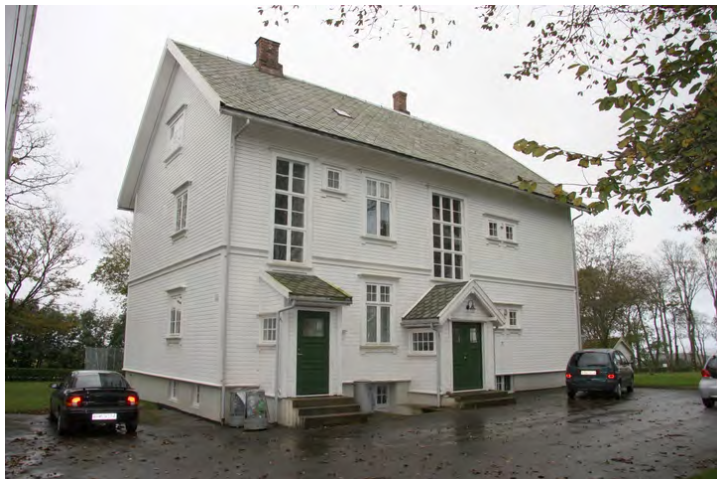
Hvitgata 2 var opprinnelig tomannsbolig for høyere funksjonærer. Opphavsrett: Statsbygg.
