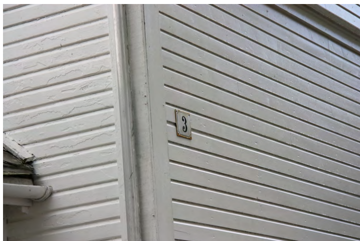
Blanding av eldre og nyere panel. Opphavsrett: Statsbygg.
