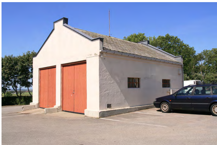
Brannstasjon. Dører mot sør, vinduer mot øst. Opphavsrett: Statsbygg.
