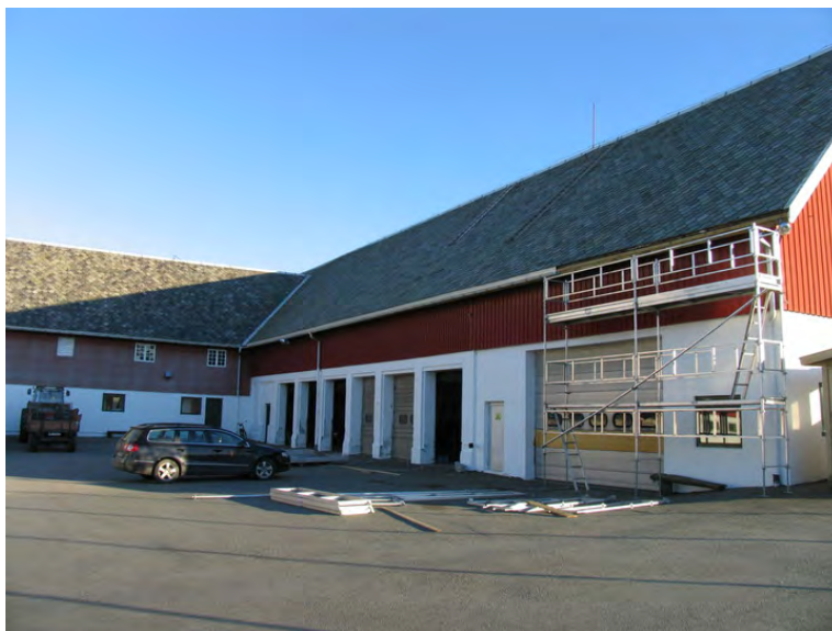
Vognskjul og stall. Opphavsrett: Kriminalomsorgen.
