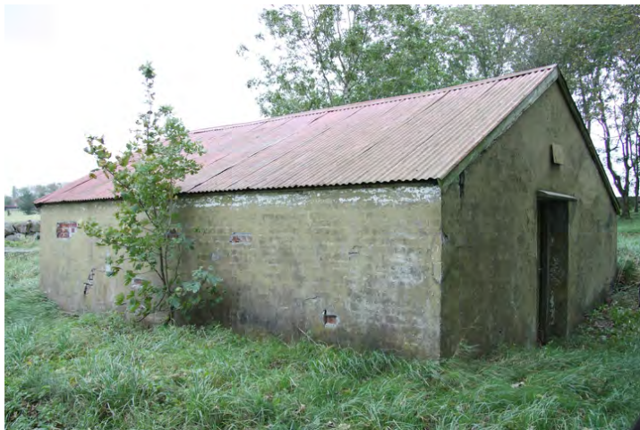
Pumpehuset er oppført i pusset tegl. Opphavsrett: Statsbygg.
