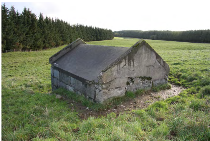
Bygningen er plassert på et jorde, et godt stykke fra bebyggelsen. Opphavsrett: Statsbygg.
