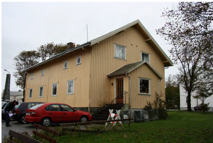
Hybelhuset ble oppført som en av de første bygningene på Åna. Her bodde bygningsarbeidere den første tiden. Opphavsrett: Statsbygg.
