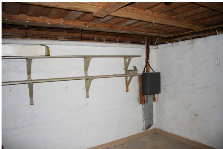
Lagerbod i kjelleren. Opphavsrett: Statsbygg.
