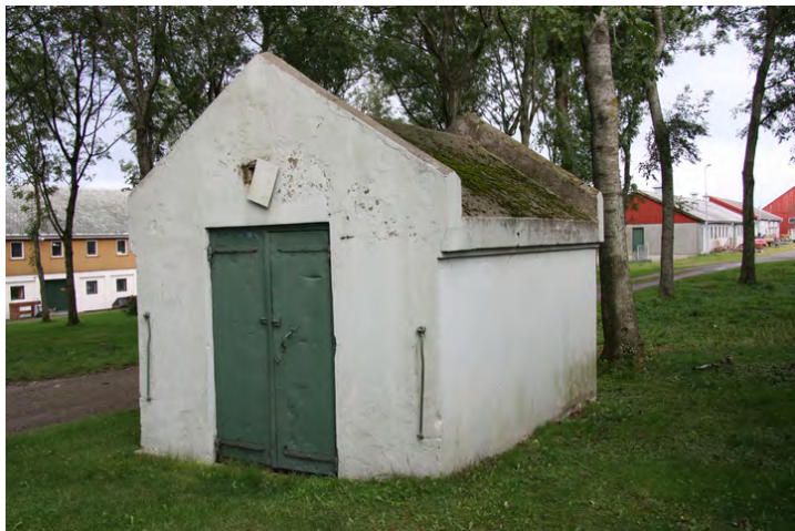
Bensinhus for lagring av brennbare væsker. Tømmermannsverkstedet sees i bakgrunnen til venstre. Opphavsrett: Statsbygg.
