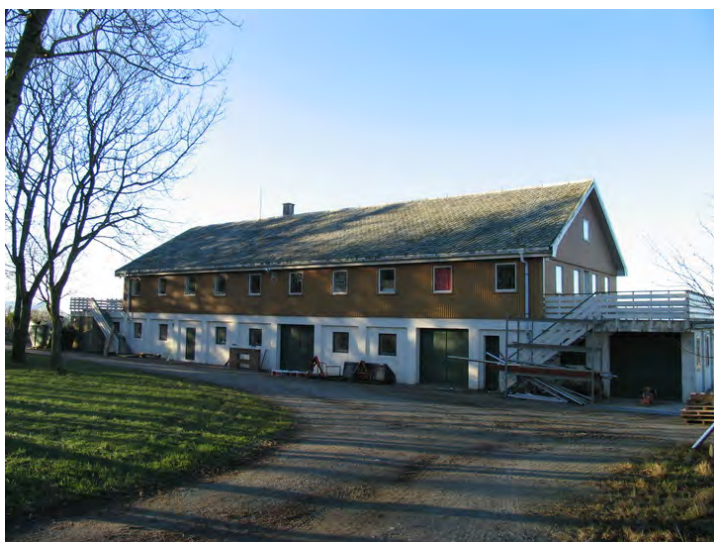
Tømmerverksted fra 1926. Fasade mot øst. Opphavsrett: Kriminalomsorgen .
