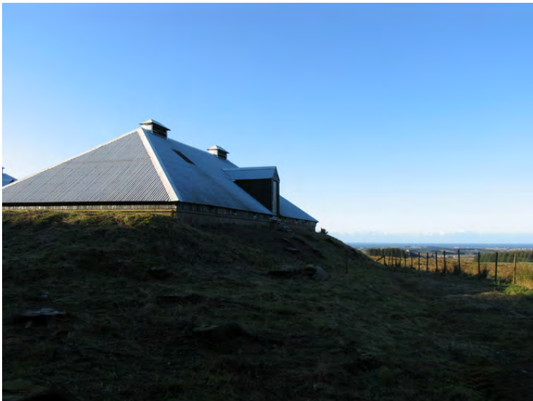
Ett av to like vannbasseng. Opphavsrett: Kriminalomsorgen.
