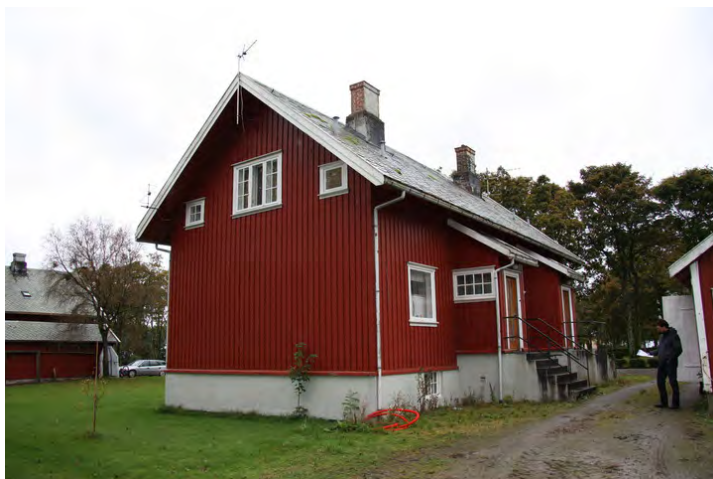
Fasade mot øst. Opphavsrett: Statsbygg.
