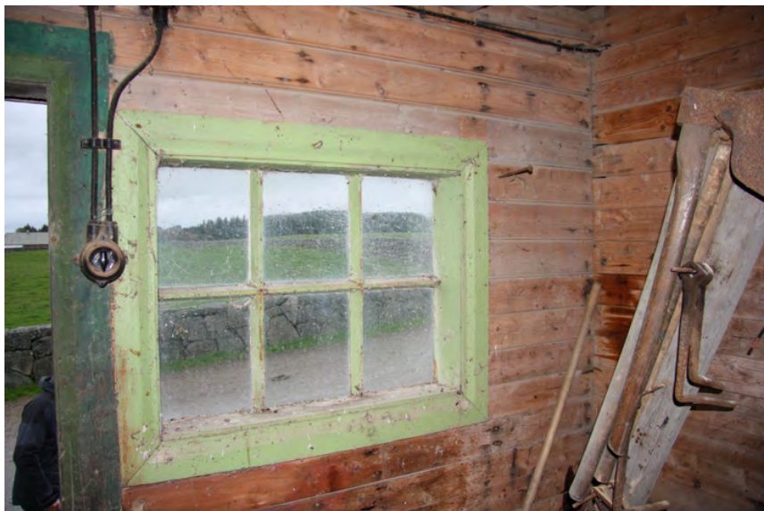
Eldre vindu intakt. Opphavsrett: Statsbygg.
