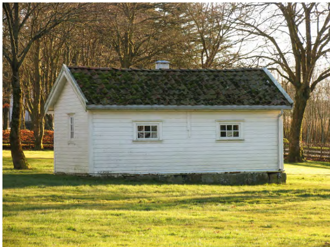
Uthusets fasade mot nordvest. Opphavsrett: Kriminalomsorgen.
