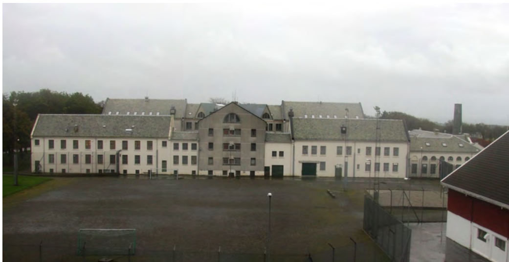
Hovedbygningens bakside, sett fra kornsiloen. Rødgata mot venstre. Opphavsrett: Statsbygg.
