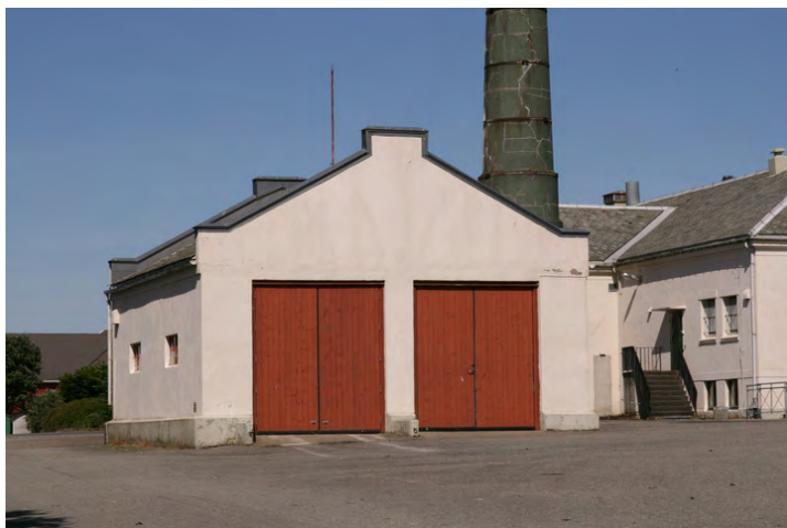
Brannstasjon for oppbevaring av utstyr til brannslukking. Opphavsrett: Statsbygg.
