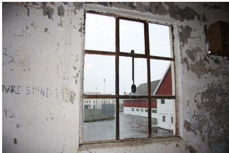
Eldre støpejernsvindu i silotårnet. Opphavsrett: Statsbygg.
