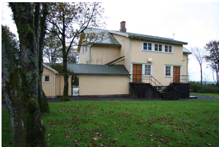
Fasadene mot nord. Opphavsrett: Statsbygg.
