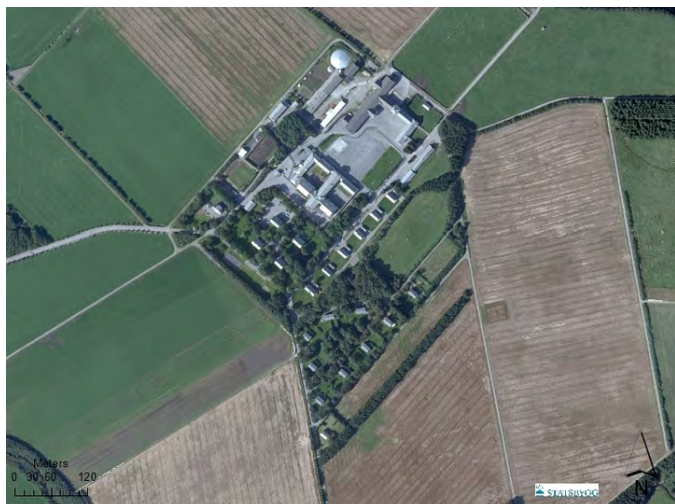
Åna fengsel - flyfoto. Opphavsrett: Statsbygg.
