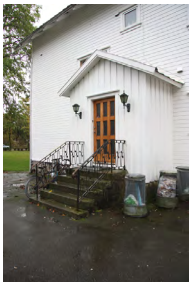
Inngangsparti. Opphavsrett: Statsbygg.
