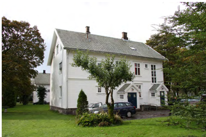
Hvitgata 3 er det siste huset før hovedbygningen. Direktørboligen skimtes bakenfor. Opphavsrett: Statsbygg.
