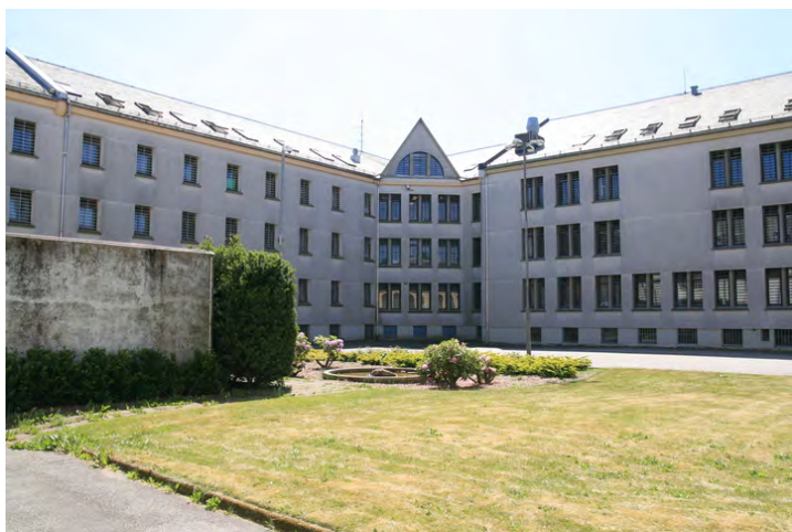
C-fløyen til venstre og B-fløyen til høyre. Sentralhall i midten. Fasader ut mot luftgården, dvs. mot nordvest. Gård for individuell lufting til venstre i bildet. Opphavsrett: Statsbygg.
