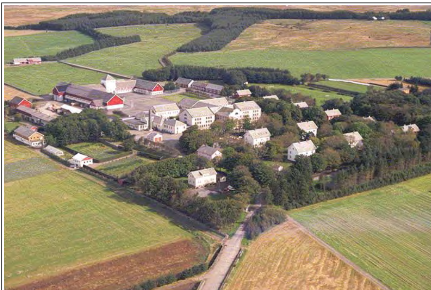
Flyfoto. Opphavsrett: Kriminalomsorgen.
