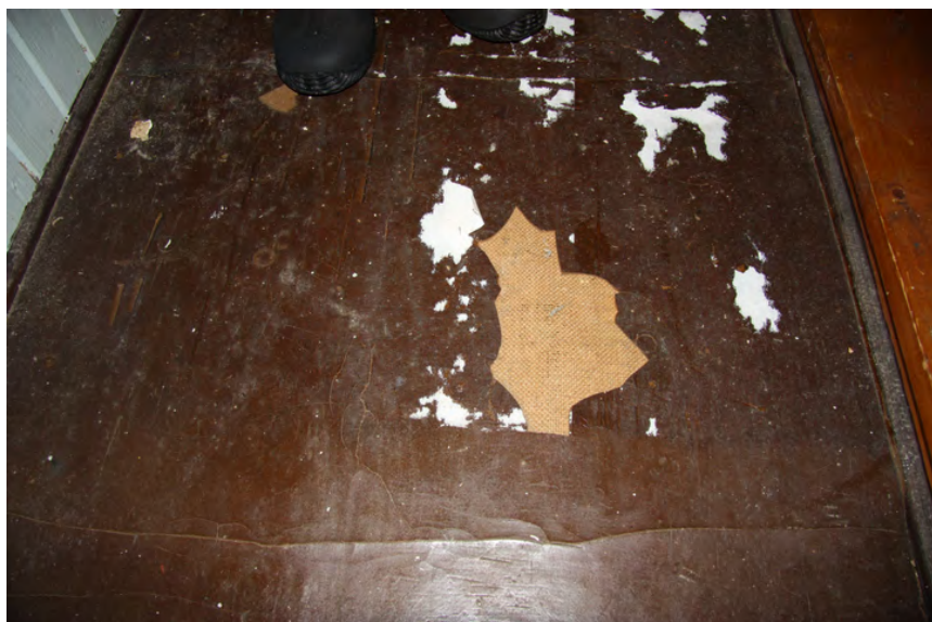
Eldre linoleum på strie på loftsgulv. Opphavsrett: Statsbygg.
