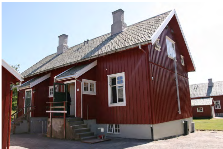
Rødgata 4. Fasade mot nordvest/Rødgata. Opphavsrett: Statsbygg.
