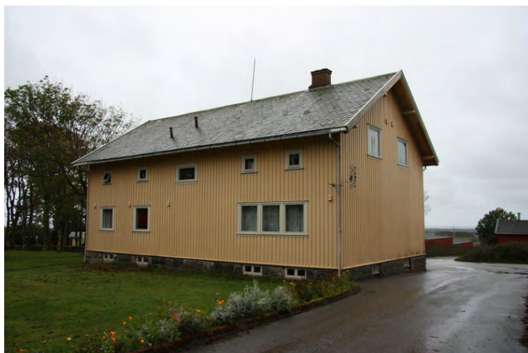
Fasade mot øst. Opphavsrett: Statsbygg.
