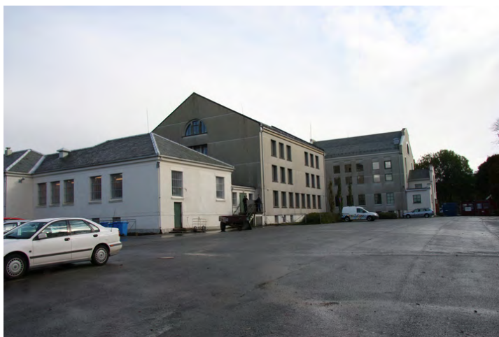
Kjøkkendelen, B-fløyen og hovedinngangen. Opphavsrett: Statsbygg.
