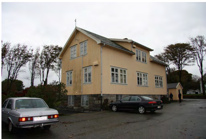
Skolebygningens fasader mot sørvest. Opphavsrett: Statsbygg.
