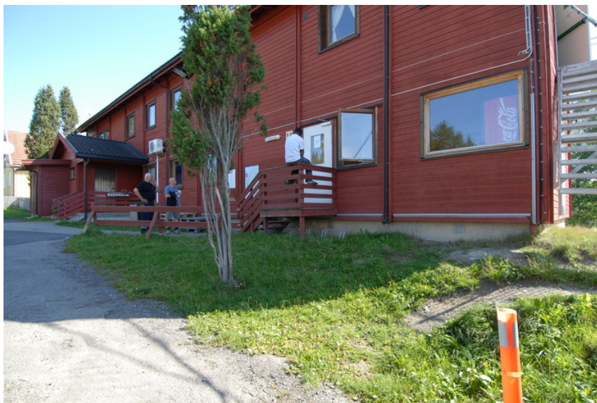
Adm.brakka sett mot NØ. Foto: Leif Anker.
