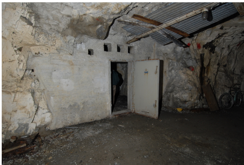
Gassluse sett fra parkeringsstoll. Foto: Leif Anker, Forsvarsbygg.
