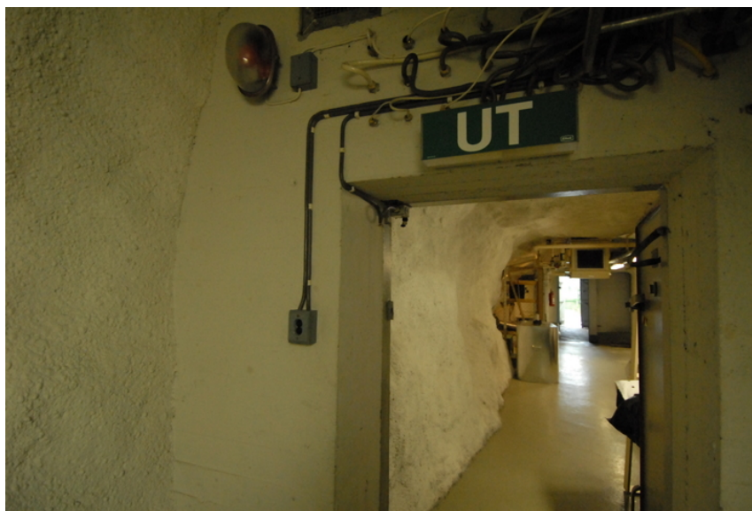
Inngangssluse, innside. Foto: Leif Anker, Forsvarsbygg.
