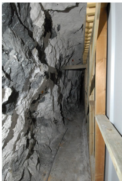
Oppbygging forlegningsrom v. stoll. Foto: Leif Anker, Forsvarsbygg.
