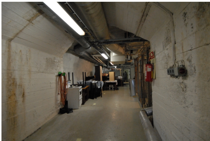
Garasje og inngangssluse. Foto: Leif Anker, Forsvarsbygg.
