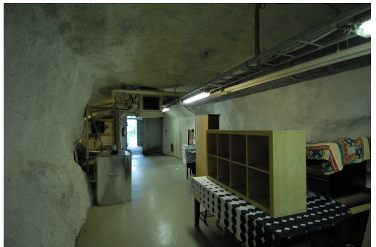
Garasje mot trykddør og utgang. Foto: Leif Anker, Forsvarsbygg.
