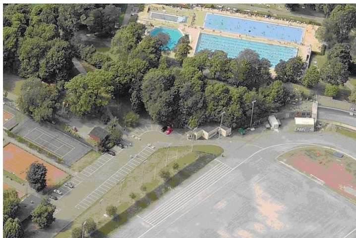
Anlegget, sett mot V, ligger i den skogkledte kollen midt i bildet. Opphavsrett: Hentet fra gulesider.no.
