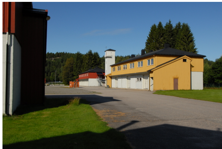
Leiren sett mot V, med f.v. hhv. bygg 4, 2 og 3. Foto: Leif Anker.
