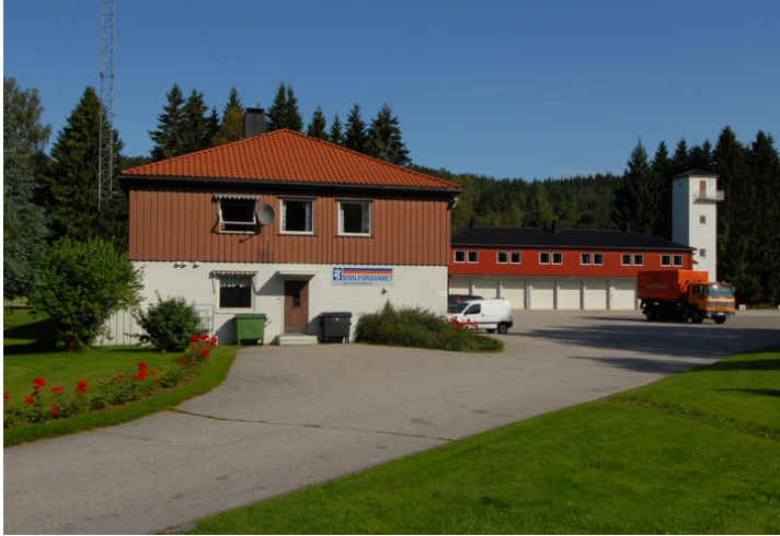
Bygningstiljø sett mot N, med adm.bygg foran og bygg 2 bak. Foto: Leif Anker.
