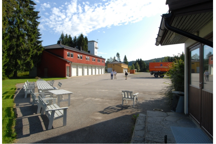
Sett mot NØ: F.h. adm.bygg, bygg 3 og bygg 2. Foto: Leif Anker.
