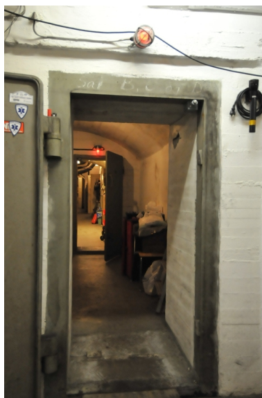
Gassluse til tverrkorridor. Foto: Leif Anker, Forsvarsbygg.
