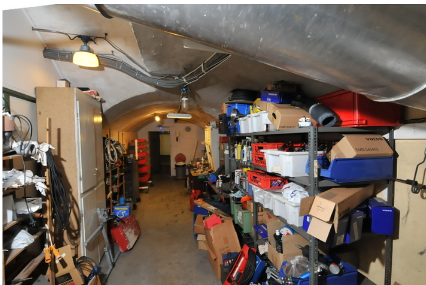
Tverrkorridor mot gassluse. Foto: Leif Anker, Forsvarsbygg
