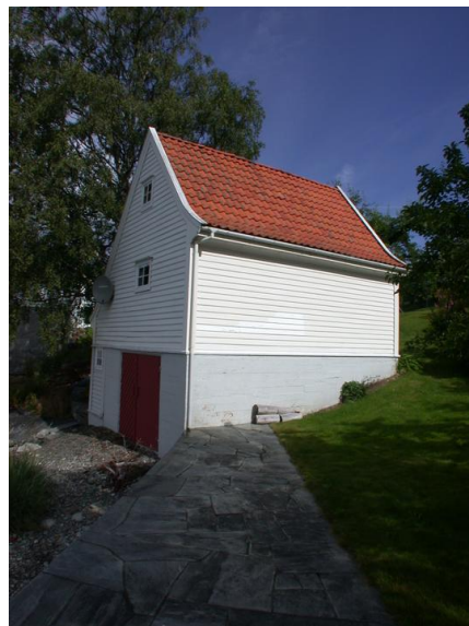
Fasade sørøst. Opphavsrett: Statsbygg.
