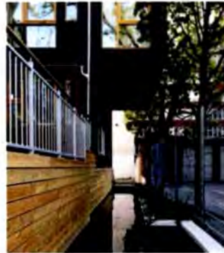
Christian Krohgs gate 12 - Overvannshåndtering som element i utformingen av uteoppholdsarealet.
