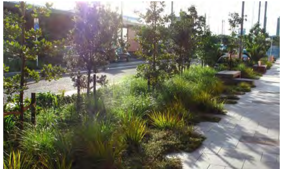
Regnvannsgrøft i gaterom,
