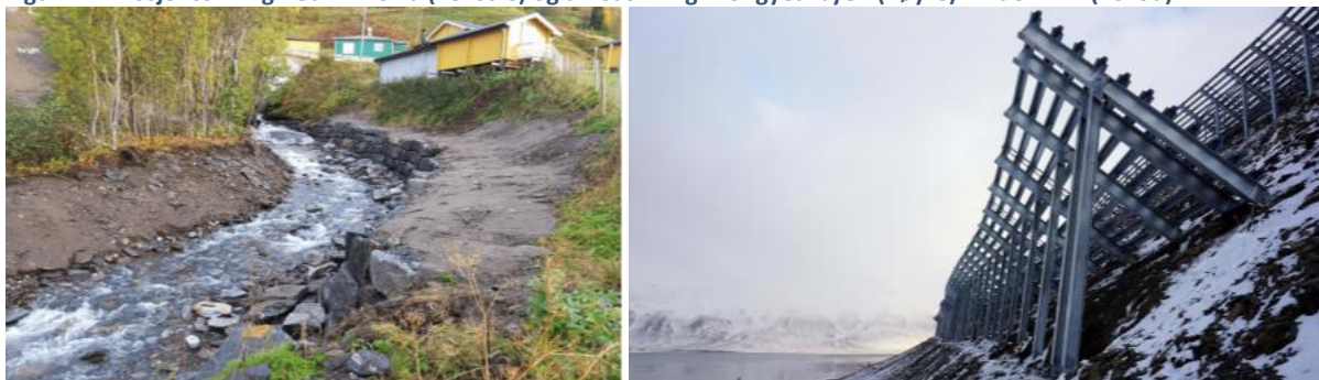
Figur 4.1 Erosjonssikring i Gamvikelva (venstre) og skredsikring i Longyearbyen (høyre). Kilde: NVE (2019a)
