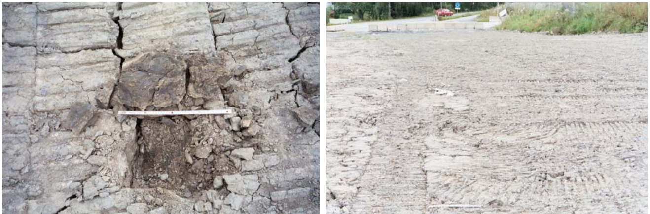
Figur 8. Utplanert undergrunnsjord av siltig mellomleire for gjenetablering av jordbruksareal. Opprasket matjordlag med ugras er synlig i øvre høyre kant på bildet til høyre.
