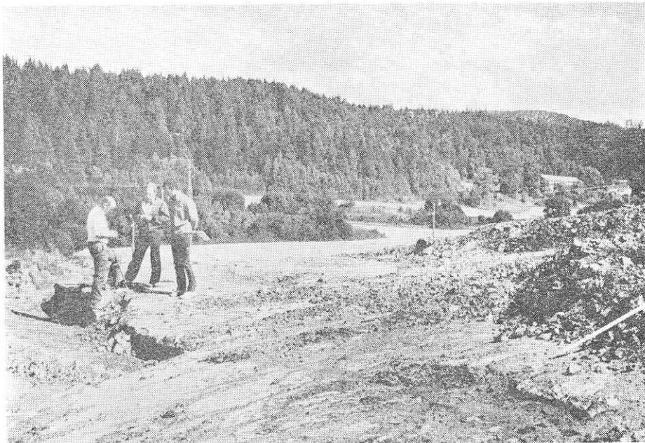
Figur 1. Avskrappt fjelloverflate i forgrunnen til venstre på Stenberghaugen, Nedre Eiker, klar for påfylling av jordmasse. Fjelloverflata har omtrent samme form som ferdig oppfylt areal skal få (fra Låg 1981).
