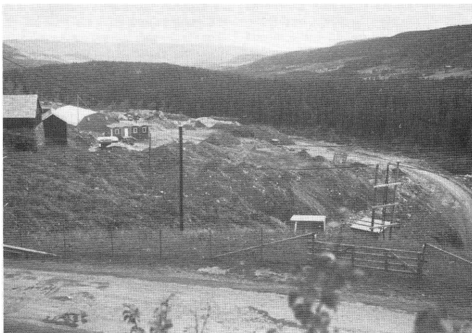
Figur 5. Anleggsarbeid med utlegging av sprengstein på Hølo (fra Vigerust & Njøs 1987).
