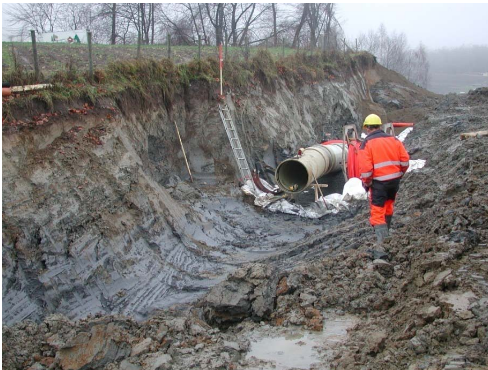
Figur 11. Graving av vannledning gjennom jordbruksområde i Lier.
